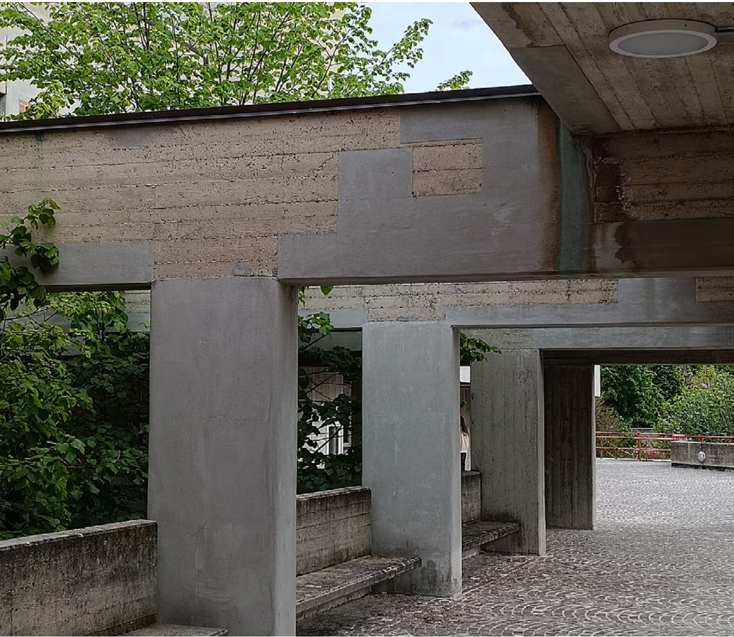
00. Collegio del Tridente. Le nuove integrazioni sul c.a. a vista e gli interventi di miglioramento sismico (Foto A. Cattaneo, 2024).
