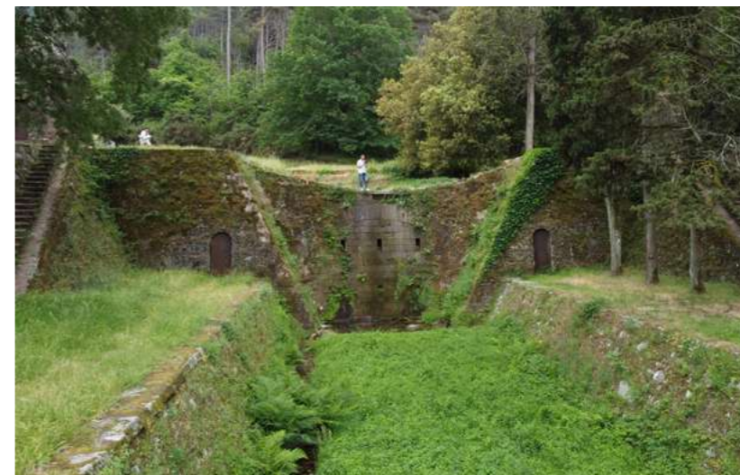
Foto della Serra Vespaia, costruita trasversalmente ai due rii, è il punto di confluenza delle acque del Rio S. Quirico e del Rio della Valle. Contiene un sistema di filtraggio attraverso cui passava l'acqua | Photo of Serra Vespaia, built transversely to the two streams, is the confluence point of the waters of Rio S. Quirico and Rio della Valle. It contains a filtration system through which the water passed
