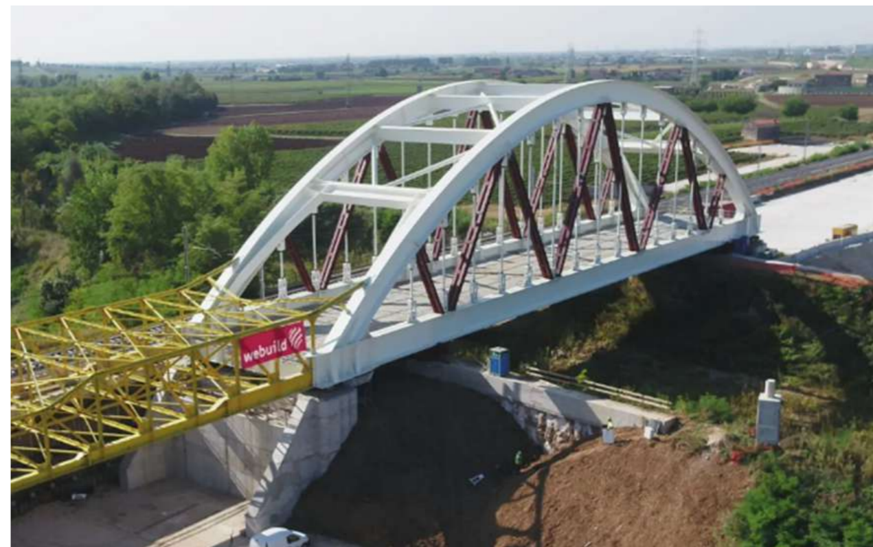
03. Ponte Caso Studio (Vicenza, Italia) | Bridge Case Study (Vicenza, Italy)
