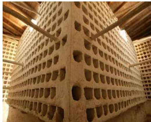
Architetture di terra - Vista della struttura interna
