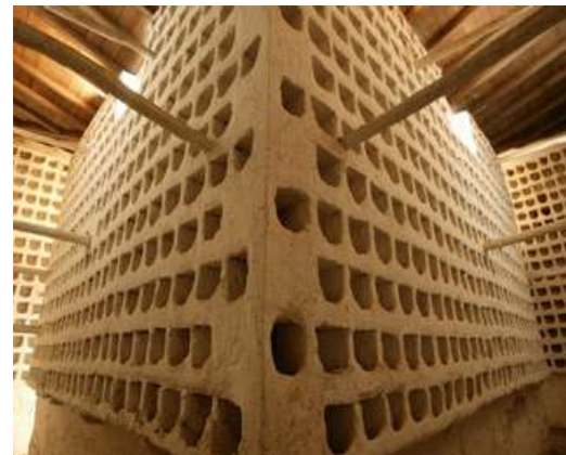
Architetture di terra - Vista della struttura interna
