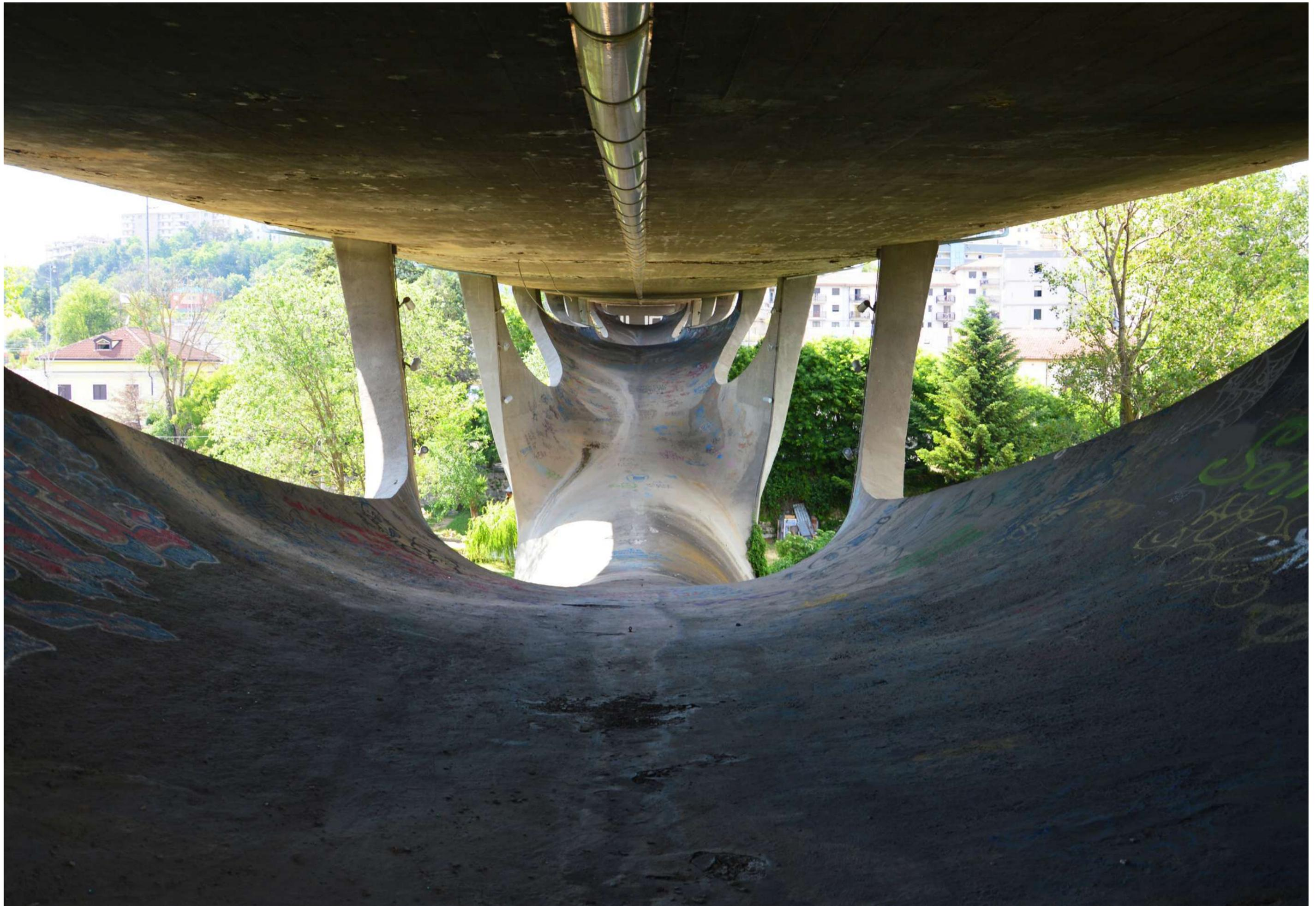
una struttura a cassone composta da una sequenza di travi continue su quattro appoggi. L'intera volta, invece, è stata costruita cominciando dalle parti situate direttamente sulle fondazioni e dopo sono state eseguite le singole campate. Una forma alquanto insolita ma che, nella fase di cantiere, si è avvalsa di procedimenti tradizionali: casseforme in legno su centinature sempre in legno sorrette da ponteggi tubolari e getto in opera
