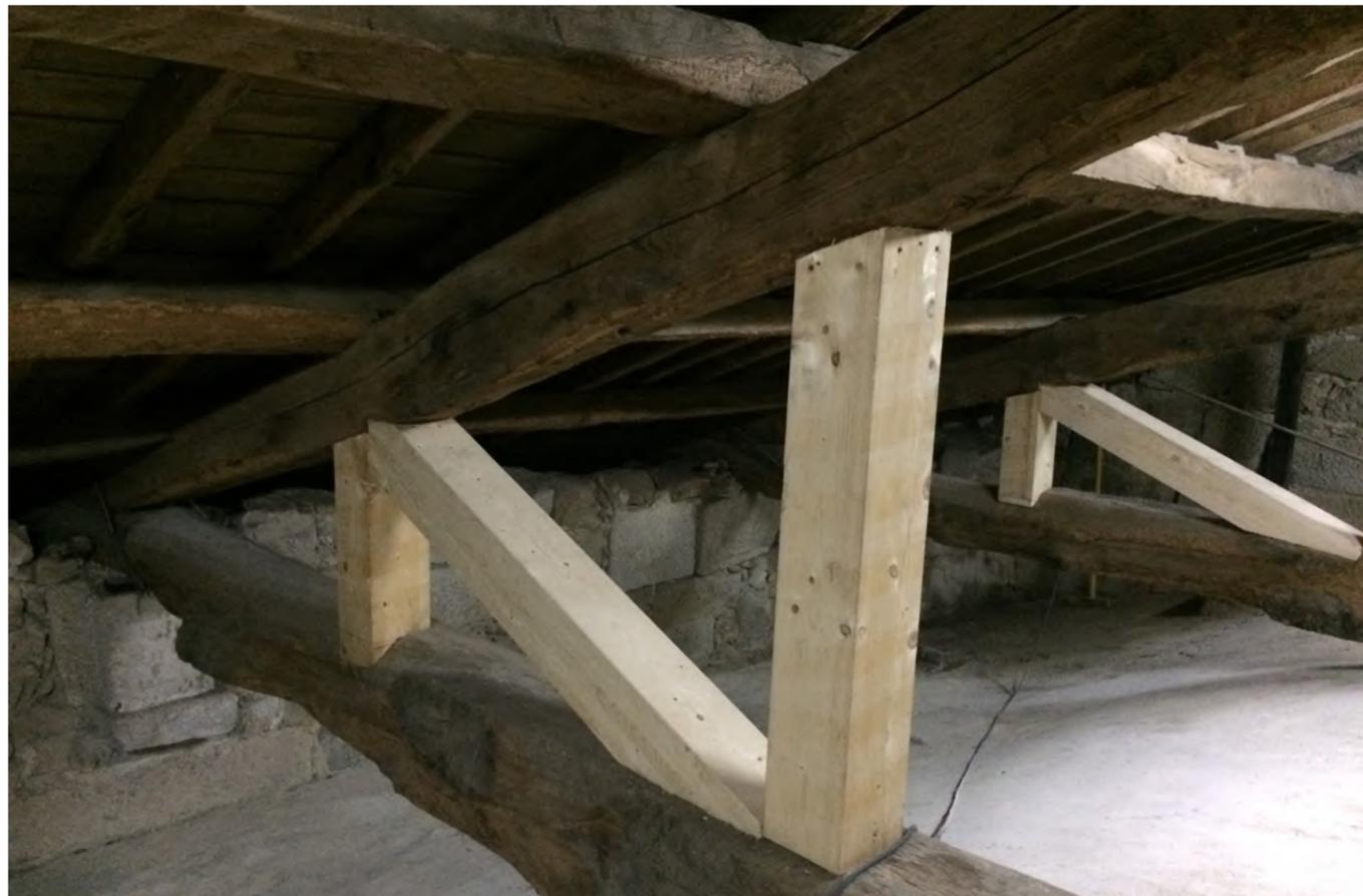
05. Particolare di recupero del legname strutturale del tetto | Detail of recovery of the structural timber of the roof
