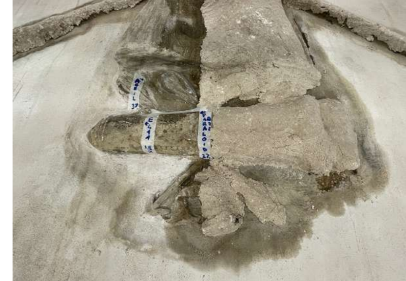
05. Dettaglio delle operazioni di restauro delle panoplie in arenaria: sul lato destro l'applicazione di impacchi per la pulitura della superficie, sul lato sinistro si evidenziano le prove di diversi prodotti consolidanti | Detail of the restoration operations on the sandstone panoplies: on the right side the application of packs to clean the surface, on the left side the testing of different consolidating products
