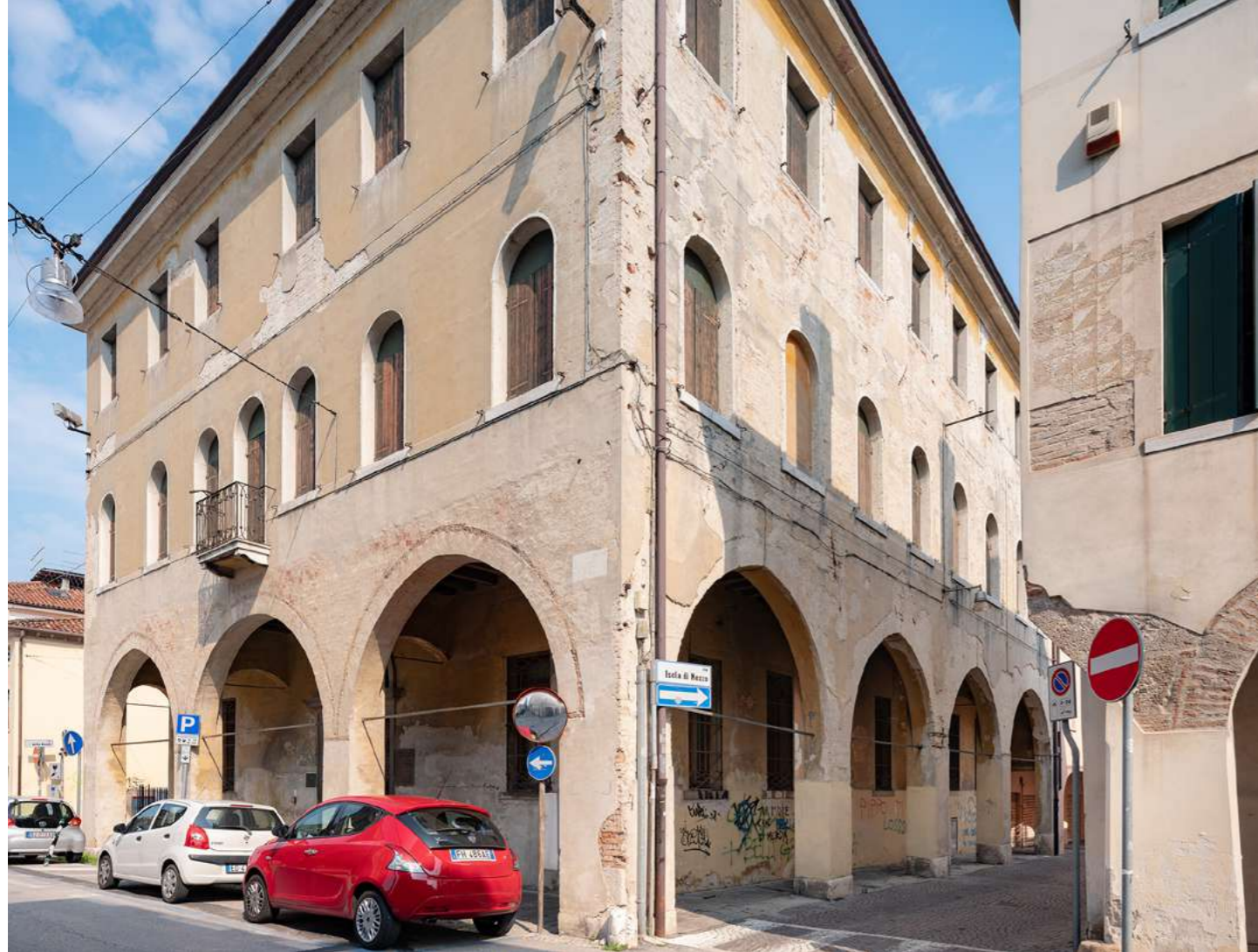
01. Palazzo della Luce, stato di fatto pre-intervento | Palazzo della luce, pre-intervention state
