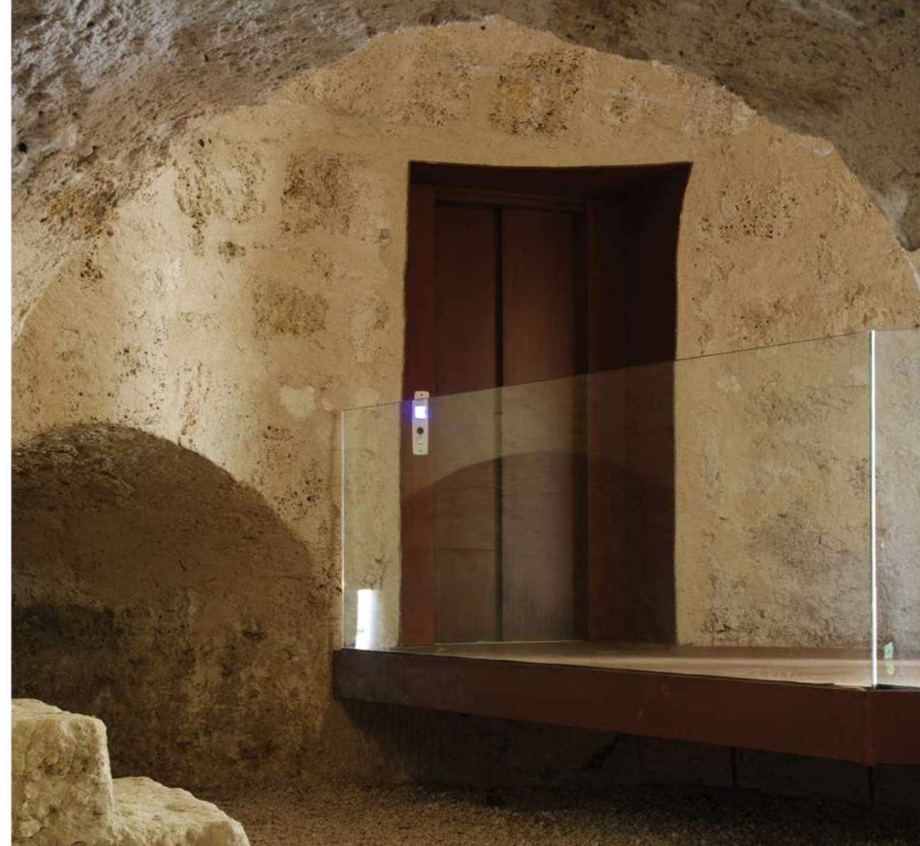
05. La passerella del vano inferiore e l'accesso all'ascensore | The gangway in the lower room and the entry of the lift
