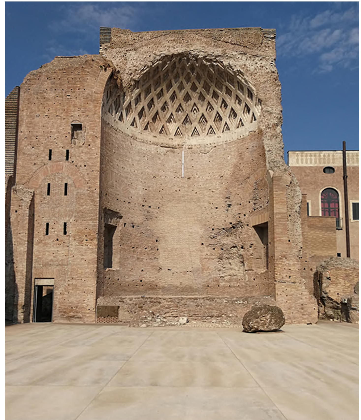
05. La nuova pavimentazione della cella di Venere suggerisce l'antica scansione del pavimento originario facendo uso di una tecnica - quella del battuto in cocciopesto - materialmente e cromaticamente compatibile con il delicato contesto archeologico | The new flooring of the chamber of Venus suggests the ancient scanning of the original floor using a technique - that of rammed terracotta - materially and chromatically compatible with the delicate archaeological context
