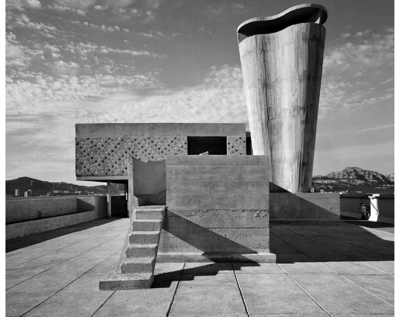
Le Corbusier, vista della copertura dell' Unité d'Habitation con sullo sfondo l'area dei calanques, 1946-1952 Le Corbusier, view of the flat roof of the Unité d'Habitation , against the background of the Calanques, 1946-1952
