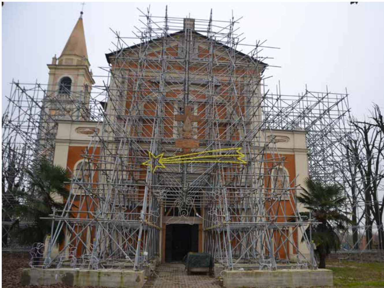
Concordia sulla Secchia (MO). Messa in sicurezza della chiesa di San Paolo (Ing. Andrea Giannantoni) Concordia sulla Secchia (MO). Structural support of San Pietro Apostolo Church (Eng. Andrea Giannantoni)
