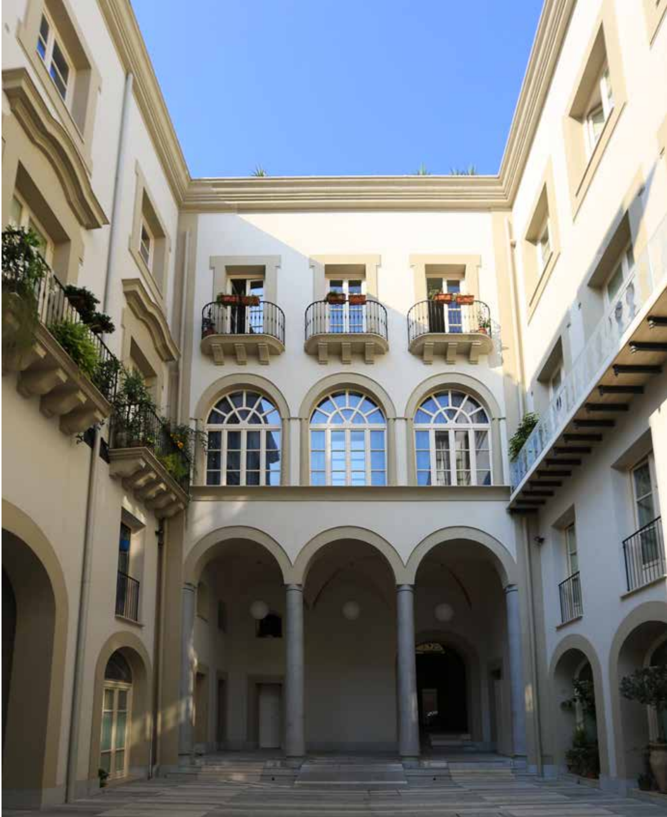
Vista della corte interna completamente ricostruita.
