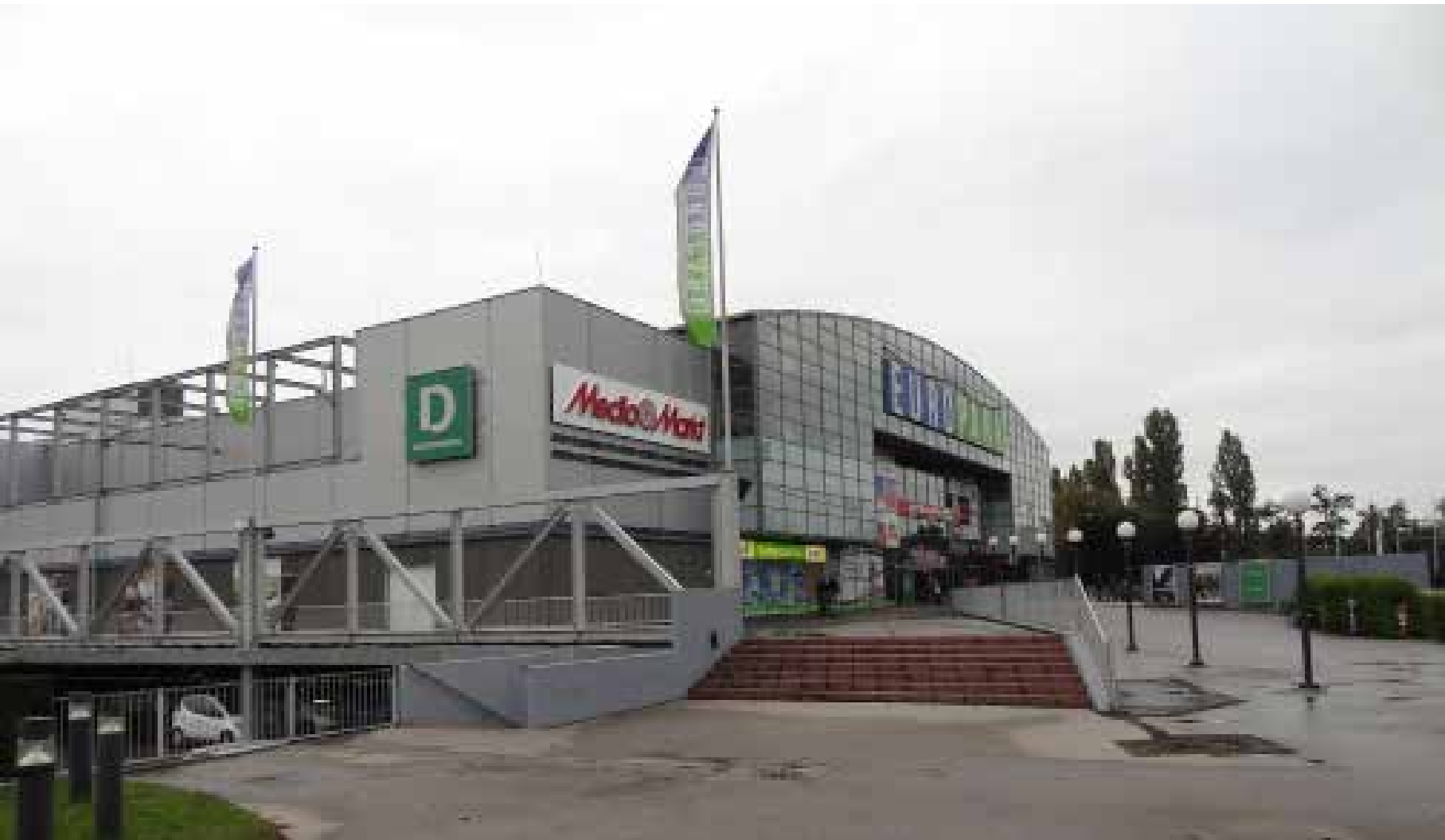
Vista esterna prima dell'intervento External view before the restyling
