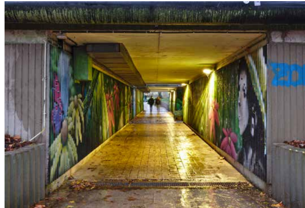
Un sottopassaggio degradato, Ottignies-Louvain-la-Neuve
