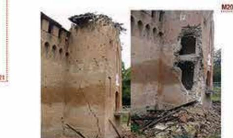
Lesione (20 maggio 2012) e successiva espulsione (29 maggio 2012) dell'angolo nella torre d'ingresso settentrionale, dovuta alla messa in opera di solai in cemento, durante un restauro precedente.
