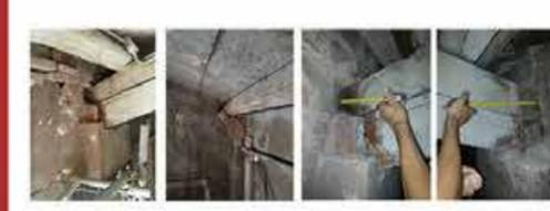
L'entità dello spostamento è confermata dal rilievo dello spostamento occorso alla trave in legno in appoggio sulla muratura perimetrale stessa. Infatti, in corrispondenza dei punti A e B è stato possibile misurare e confrontare lo spostamento della trave di capriata con le misure di fuori piombo della parete
