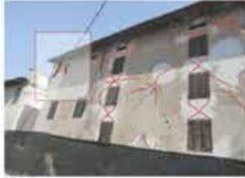
in angolo è possibile identificare il cinematico di ribaltamento del cantile dovuto all'azione sismica. Lesioni passanti con leggeri spostamenti fuori piano delle murature, sono presenti lesioni da taglio lungo gli architravi delle aperute.
