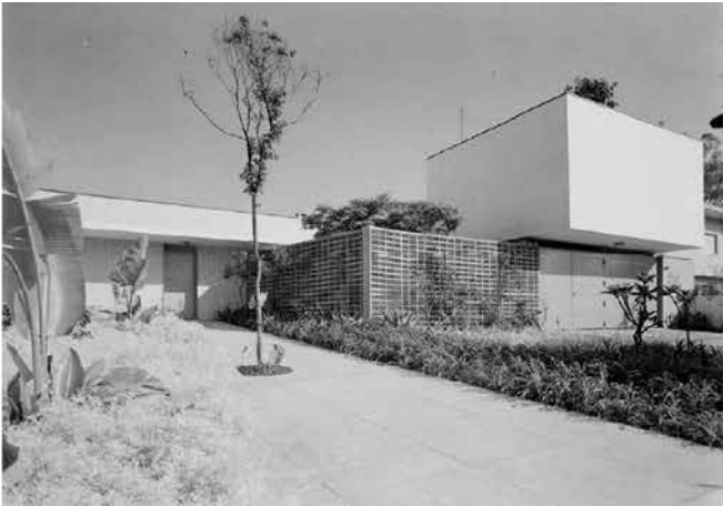
Foto originale dell'edificio (1959)
