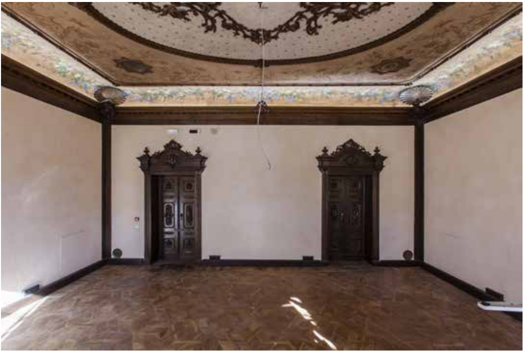
BinarIOLab, restauro di Palazzo Gulinelli – Canonici Mattei, Ferrara. Un ambiente durante i lavori ed a lavori completati
