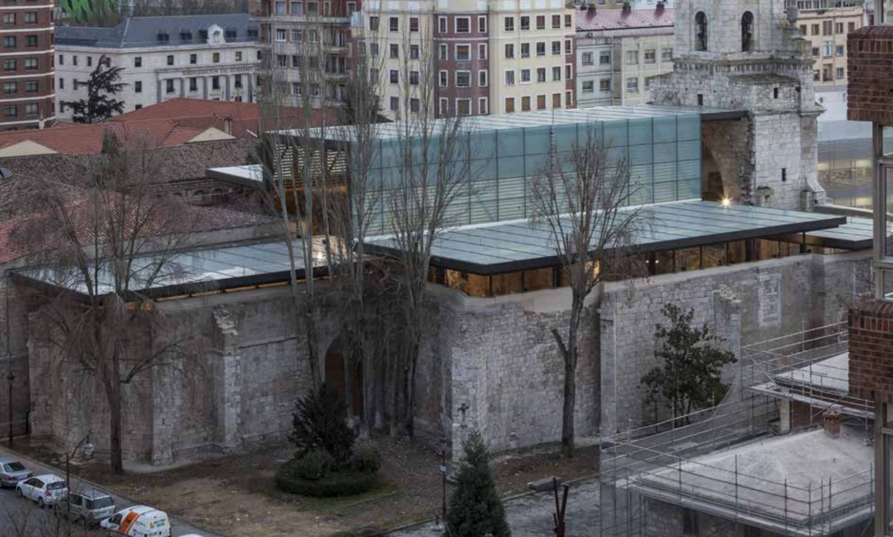
Vista complessiva del nuovo sistema di coperture
