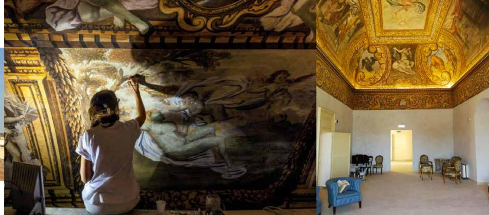
modellato in stucco e da una bicromia riscontrata mediante opportuni sondaggi è stato oggetto di una sicura riproposizione del testo ottenuta mediante la conservazione degli stucchi e delle finiture originali, l'integrazione - laddove necessario - del modellato ed una revisione cromatica complessiva. Infine, particolare attenzione è stata riservata al recupero quanto più possibile esteso degli infissi lignei storici.
