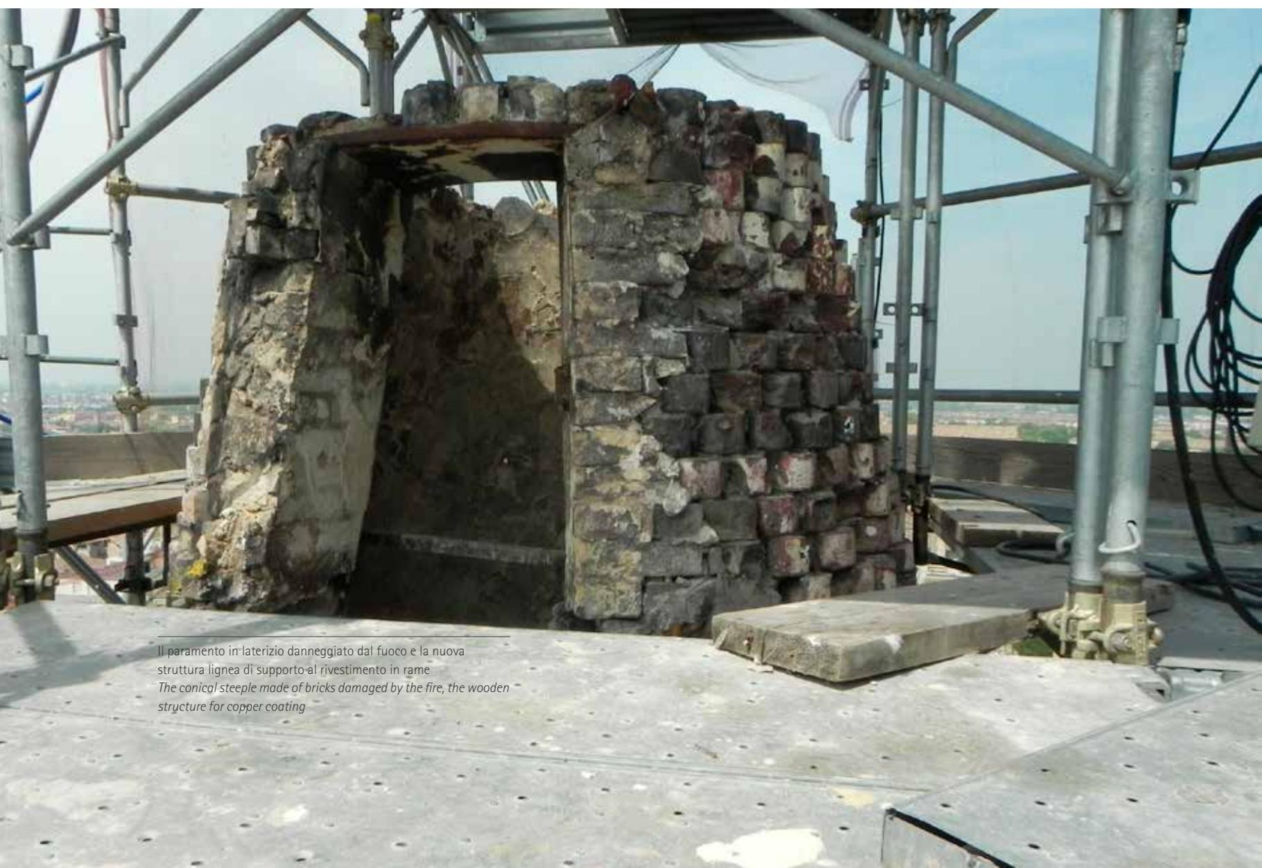
Il paramento in laterizio danneggiato dal fuoco e la nuova struttura lignea di supporto al rivestimento in rame
