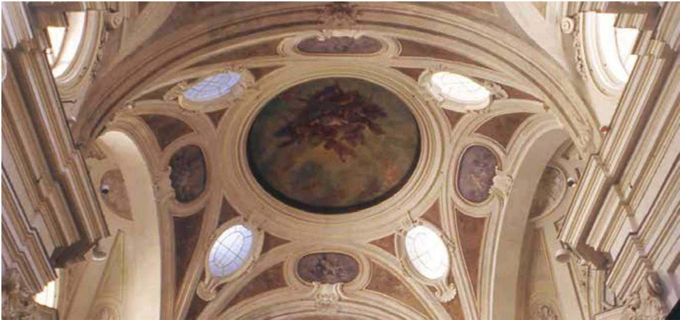
Gli interventi, risanamento delle murature umide degli ambienti controterra, reintegrazione e sostituzione degli intonaci, reintegrazione e riproposizione delle finiture pittoriche, sono stati realizzati dalla Rosellini Restauri sas e hanno visto l'impiego dei prodotti a base di calce idraulica naturale NHL e cocchiopesto della linea EX NOVO Restauro Storico Fassa Bortolo.
