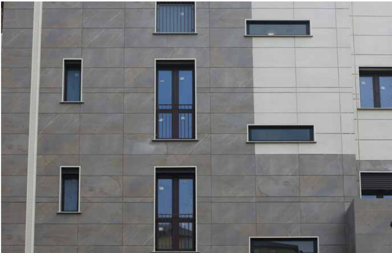
Grazie al correntino in acciaio integrato al pannello, si realizzano con un'unica soluzione tecnica una efficace ventilazione e la struttura di supporto per il rivestimento, compatibile con tutte le tipologie di finitura sia leggere che pesanti.
