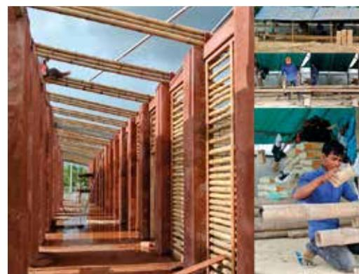
Sperimentazione per il sistema di fondazioni: creazione della maglia in bambù (in alto a sinistra) e sperimentazione per il sistema di muratura: creazione di blocchi in terra cruda asciugati al sole (a destra)
