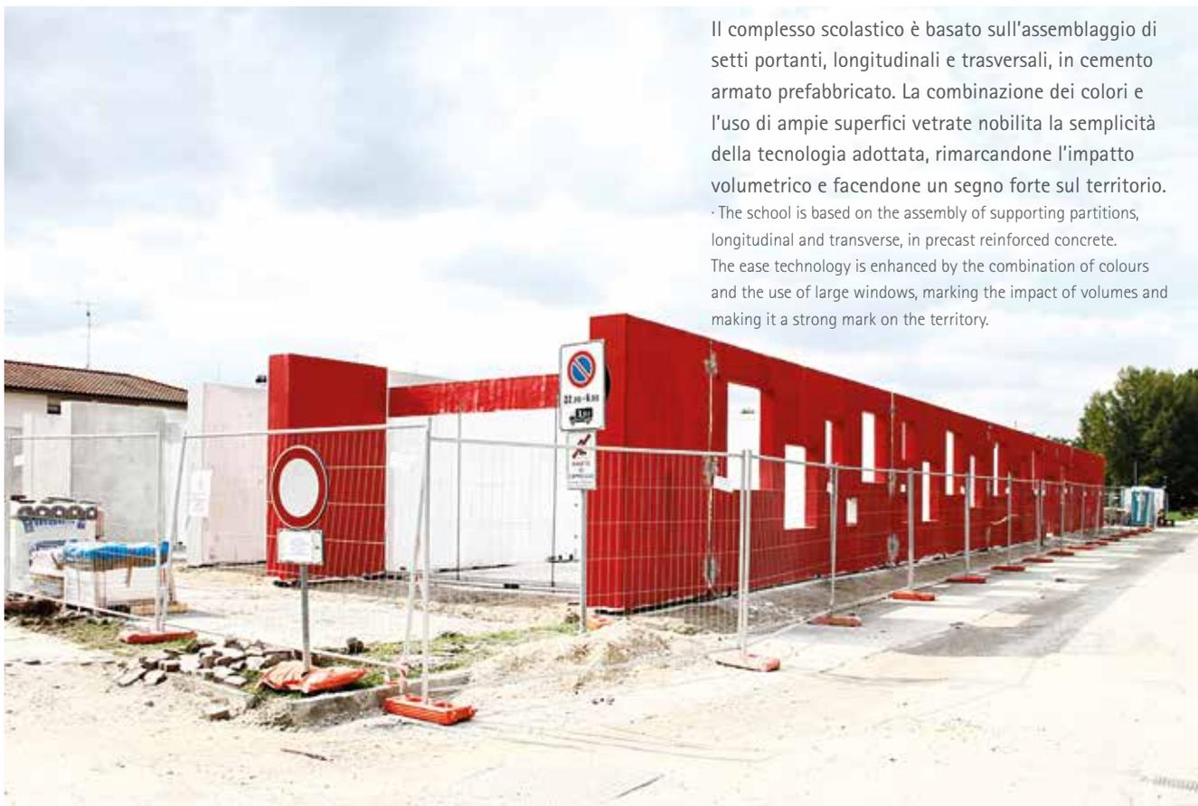
Il complesso scolastico è basato sull'assemblaggio di setti portanti, longitudinali e trasversali, in cemento armato prefabbricato. La combinazione dei colori e l'uso di ampie superfici vetrate nobilita la semplicità della tecnologia adottata, rimarcandone l'impatto volumetrico e facendone un segno forte sul territorio.
