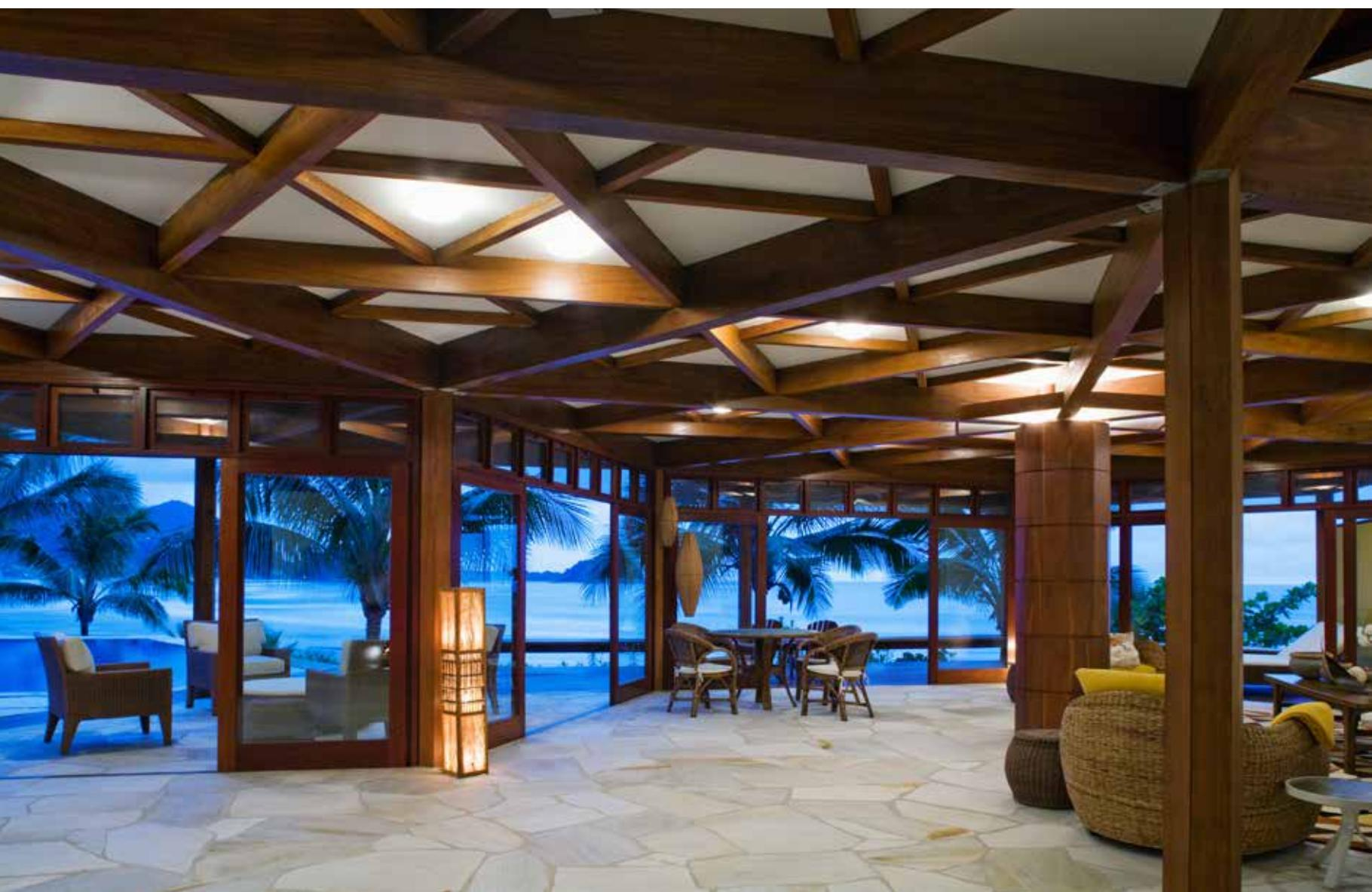
triangolare della pianta e regolano la posizione delle principali travi di sostegno. Una trama di travi secondarie che formano triangoli di 1,25 metri di lato sorregge lastre in calcestruzzo industriale leggero che sopportano il peso delle lastre di cemento di 4 centimetri di spessore del solaio.
