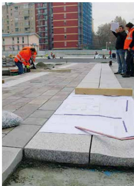
da 10 mm, alternati da fasce in granito sardo da 41 cm, spessore costante 8 cm e finitura superficiale fiammata. Le canalette di raccolta delle acque meteoriche di deflusso sono state realizzate con elementi in porfido e in granito a misura e spessori fissi, con finitura superficiale fiammata.
