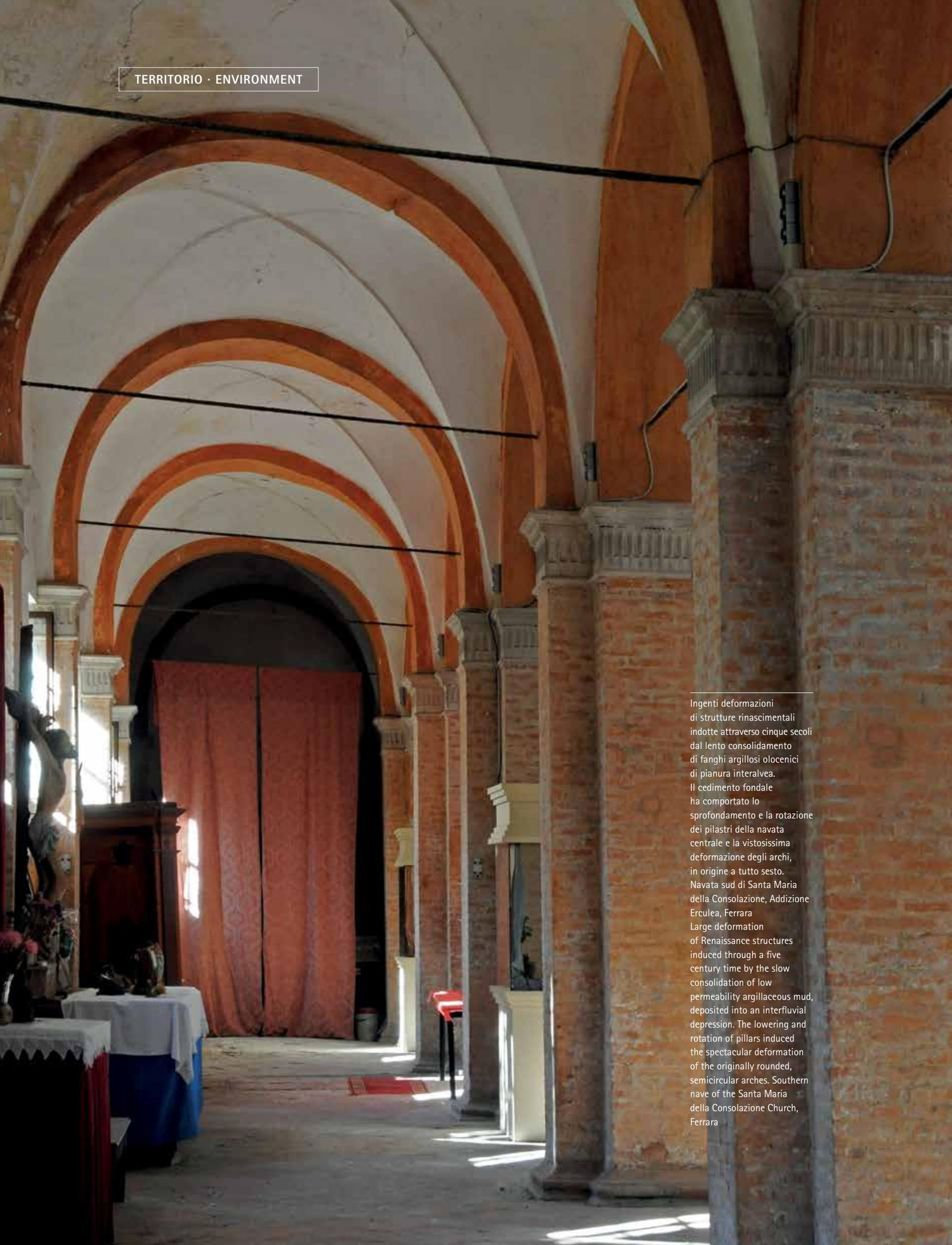
Ingenti deformazioni di strutture rinascimentali indotte attraverso cinque secoli dal lento consolidamento di fanghi argillosi olocenici di pianura interalvea. Il cedimento fondale ha comportato lo sprofondamento e la rotazione dei pilastri della navata centrale e la vistosissima deformazione degli archi, in origine a tutto sesto. Navata sud di Santa Maria della Consolazione, Addizione Erculea, Ferrara
