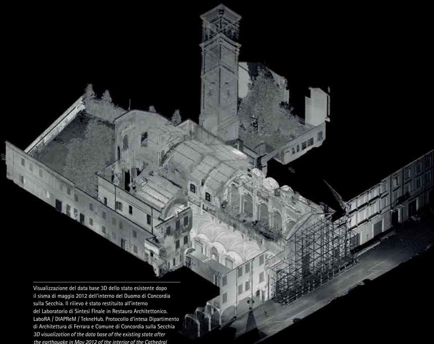
Visualizzazione del data base 3D dello stato esistente dopo il sisma di maggio 2012 dell'interno del Duomo di Concordia sulla Secchia. Il rilievo è stato restituito all'interno del Laboratorio di Sintesi Finale in Restauro Architettonico. LaboRA / DIAPReM / TekneHub. Protocollo d'intesa Dipartimento di Architettura di Ferrara e Comune di Concordia sulla Secchia
