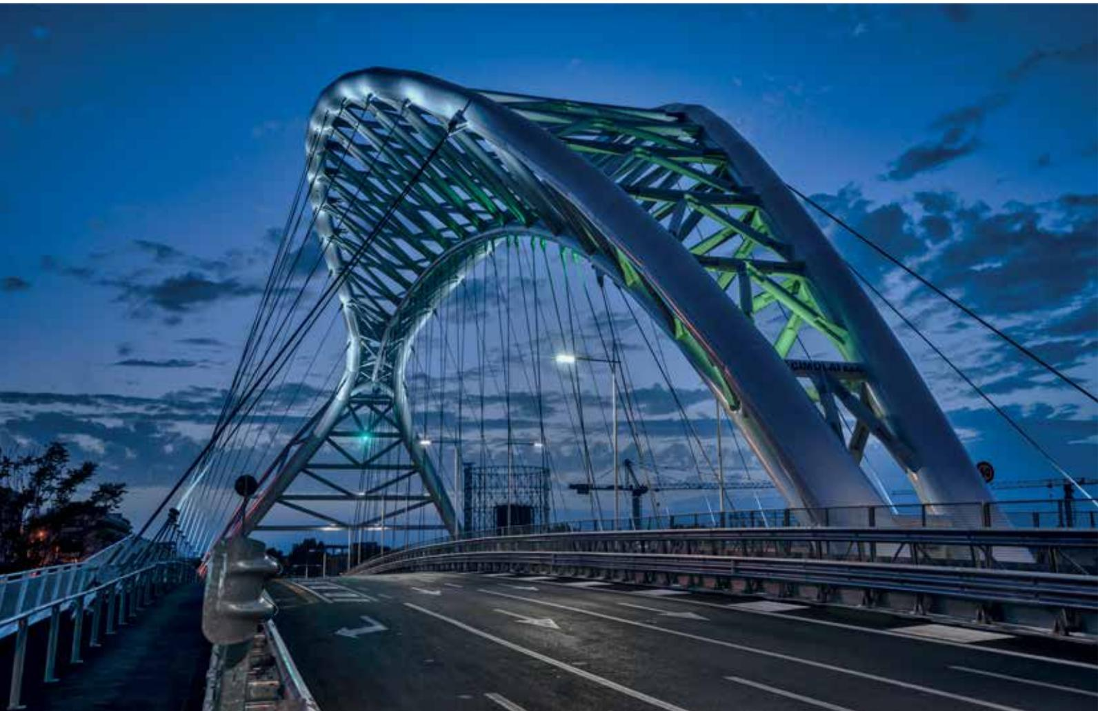
posizionati ad un'altezza di 8 metri, ad una distanza l'uno dall'altro di 30 metri su strada e di 20 metri sul ponte. Con gli apparati Cree si è raggiunto un ottimo illuminamento, con una media di 30 lux,  $U_o = 0.47$  (su strada) e di 42 lux,  $U_o = 0.59$  (sul ponte).
