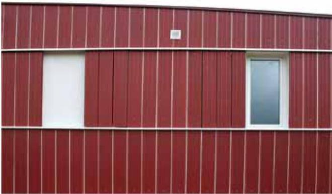
Il sistema di ombreggiamento è stato creato con le stesse tavole in legno formanti il rivestimento di tutto l'edificio. Sono state create delle cornici metalliche alle quali sono state chiodate le tavole e sono spostabili attraverso un sistema scorrevole (in basso)
