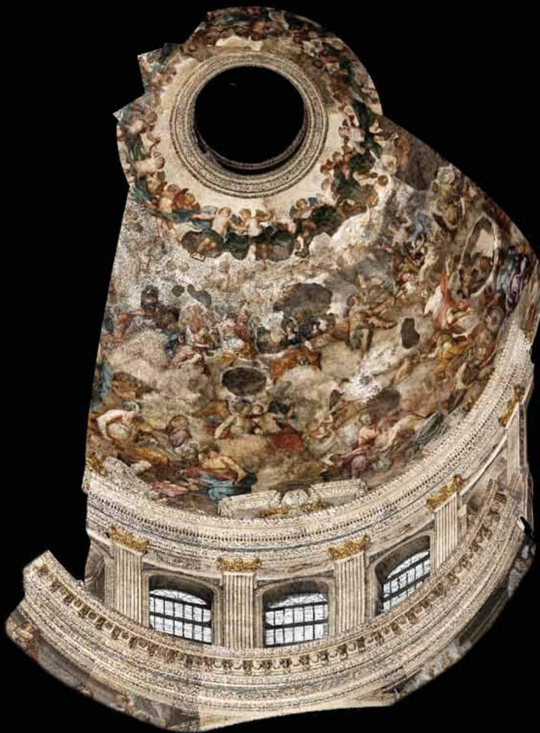
Vista prospettica a nuvola di punti di un settore dell'intradosso della cupola e del tamburo
