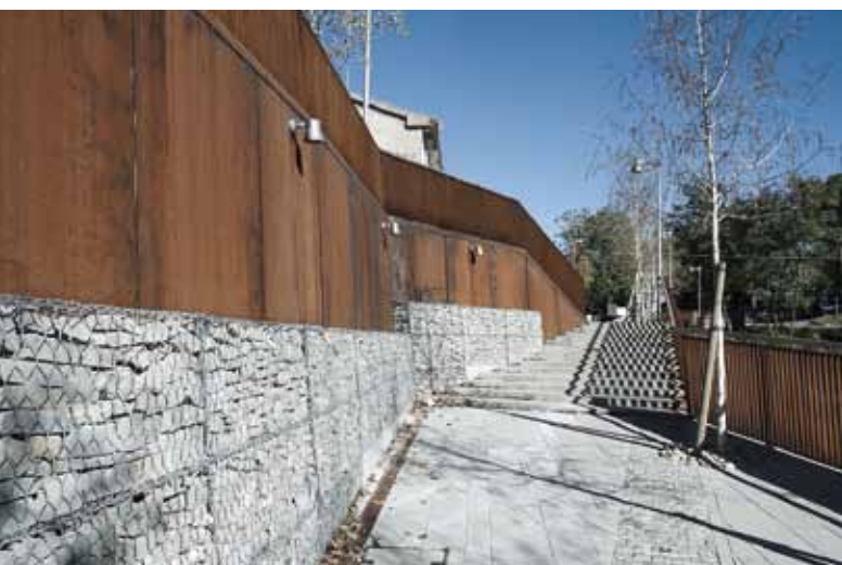
Il muro di sostegno divide a livelli il sistema di piazze è formato da acciaio corten e gabbia con rete metallica riempita con la pietra albarese scartata dalla lavorazione della pavimentazione (a sinistra) The retaining wall divides the system of squares in various levels. It is made of Corten steel and a wire mesh cage filled with Albarese stone discarded from the processing of the pavement (on the left)
