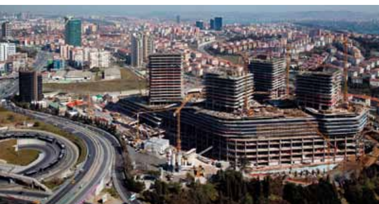
Il cantiere in costruzione The center under construction Photo © Cemal Emden
