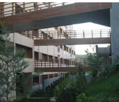
Fotografia di Kemer50 Houses che mostra gli spazi di circolazione tra gli edifici Photo of Kemer50 Houses, showing the open circulation system Photo © Boran Ekinci Architecture
