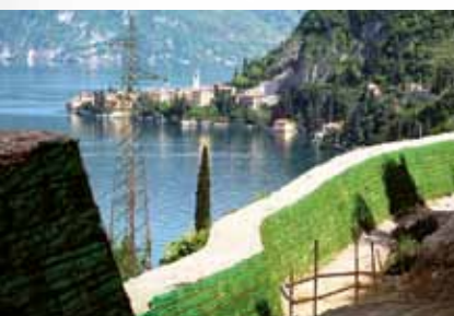
Varenna (LC): paramassi in Terra Rinforzata con Geogriglie integrali.
