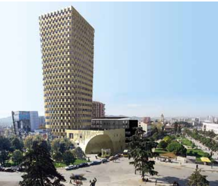
TID tower, 51N4E. Prospettiva di studio da Rruga George W. Bush e vista sull'edificio in costruzione da Piazza Skanderbeg. Fonte 51N4E, Bruxelles TID tower, 51N4E (a sinistra, in alto e al centro) Study view from Rruga George W. Bush and view of the building under construction from Skanderbeg Square. Source 51N4E, Bruxelles (on the left, above and in the middle)
