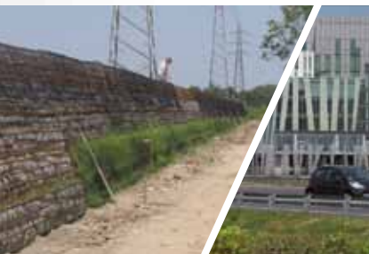
Assago (MI): Duna antirumore in Terra Rinforzata con Sistema Tenax Rivel.
