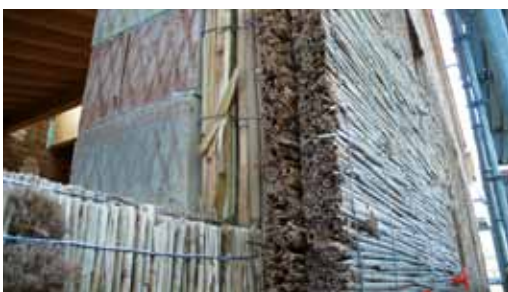
Sovrapposizione dei pannelli in cannarella (in alto) Overlapping of the cannarella panels (above)
