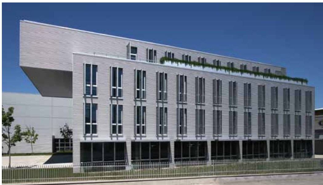
La palazzina uffici con i frangisole chiusi e aperti Office building with closed and open shading devices
