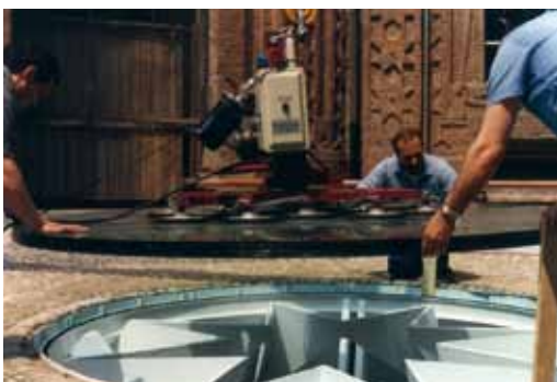
Immagine di cantiere: posa del vetro di copertura degli oblò nel cortile di Palazzo Carignano (in alto) Image of the construction site: placement of the porthole covering glass in the courtyard of Palazzo Carignano (above)
