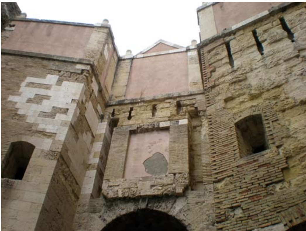
Scorci di alcune quinte urbane nel centro storico di Cagliari. Il naturale degrado delle superfici e i segni dell'invecchiamento contribuiscono al mantenimento dei caratteri identitari del luogo. Foto: Federica Maietti, 2010
