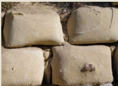
Erosione. Asportazione di materiale dalla superficie dovuta a processi di natura diversa (chimica, fisica, ambientale, ecc.). La superficie appare abrasa o "modellata" dagli agenti atmosferici
