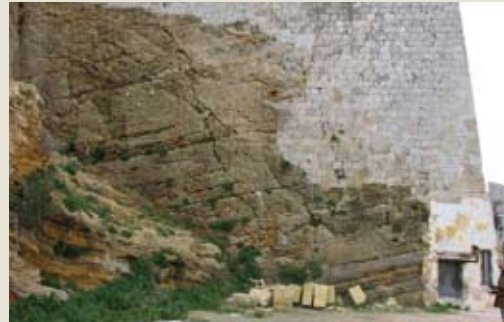
Fondazione diretta del paramento murario su strati calcarei di diverse litofacies disposti a reggipoggio
