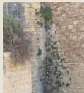
Presenza di vegetazione. Arbusti, erba, cespugli o alberi, talvolta con radici, presenti sotto, all'interno o sulla superficie dei paramenti murari
