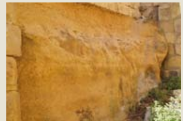
Banco compatto di biocalcarene giallastra a granulometria grossolana (wackstone-packstone) inglobato nella muratura inferiore
