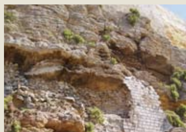
Fratture e diaclasi sviluppate sia parallelamente che perpendicolarmente agli strati biocalcarenitici, alla base della Cittadella
