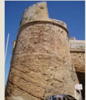
Paramento murario del bastione cilindrico a diretto contatto con strati di biocalcareni a burrow (bioturbated limestone)
