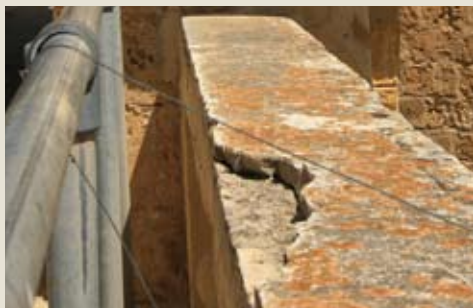
Danno meccanico. Rottura dovuta a colpi o urti accidentali o incisioni da graffiti dovuti ad atti vandalici
