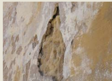
Rigonfiamento. Sollevamento localizzato e superficiale del materiale, che assume forma e consistenza variabili
