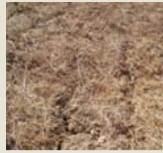
Profonde e diffuse fessurazioni da disseccamento nel Blue Clay Formation
