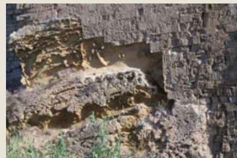
Back weathering. Perdita uniforme di strati paralleli di materiale dovuta a progressiva erosione, disgregazione, esfoliazione e distacco degli strati più esterni della pietra. Tale morfologia di degrado è da riferirsi anche agli affioramenti rocciosi, in particolare per quanto riguarda la sottoescavazione, la perdita di strati lapidei e il manifestarsi della struttura originaria dello strato roccioso
