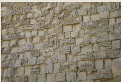
Back weathering. Perdita uniforme di strati paralleli di materiale dovuta a progressiva erosione, disgregazione, esfoliazione e distacco degli strati più esterni della pietra. Tale morfologia di degrado è da riferirsi anche agli affioramenti rocciosi, in particolare per quanto riguarda la sottoescavazione, la perdita di strati lapidei e il manifestarsi della struttura originaria dello strato roccioso
