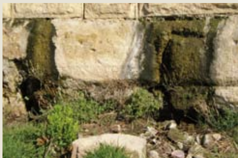
Patina biologica. Strato sottile, morbido e omogeneo, aderente alla superficie e di evidente natura biologica, di colore variabile, per lo più verde
