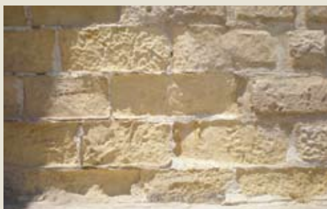
Polverizzazione. Decoesione che si manifesta con la caduta spontanea del materiale sotto forma di polvere o granuli. A tale nomenclatura è da riferire anche la disgregazione
