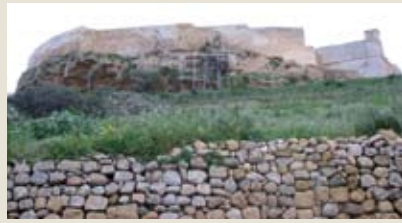
Muro di contenimento degli strati argilloso-marnosi del Blue Clay Formation
