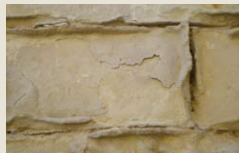
Esfoliazione. Degradazione che si manifesta col distacco, spesso seguito da caduta, di uno o più strati superficiali subparalleli fra loro (sfoglie)
