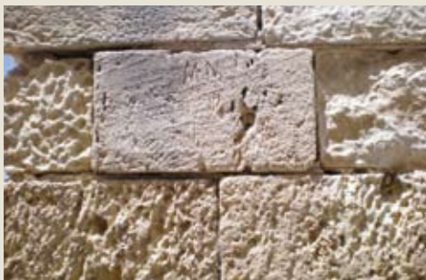
Danno meccanico. Rottura dovuta a colpi o urti accidentali o incisioni da graffiti dovuti ad atti vandalici
