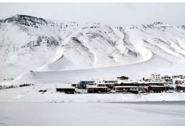
Reynir Vilhjalmsón Avalanche-protection structures Islanda, Landslag Ltd.
