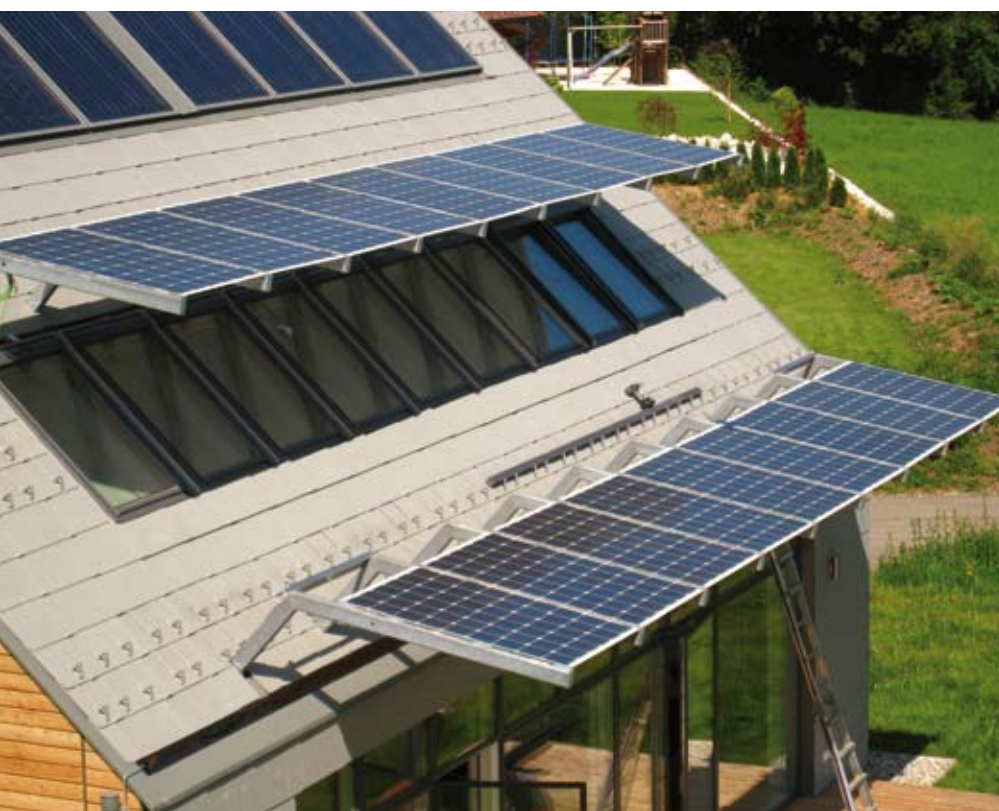
Le finestrature in copertura apribili per facilitare la ventilazione naturale e uso combinato dei pannelli solari e di quelli fotovoltaici (in basso)
