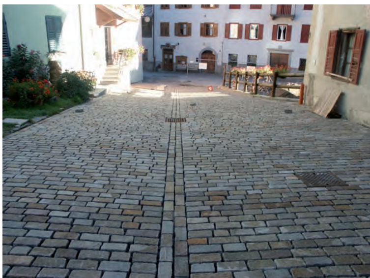
Pavimentazione in binderi prima della fase di sigillatura
