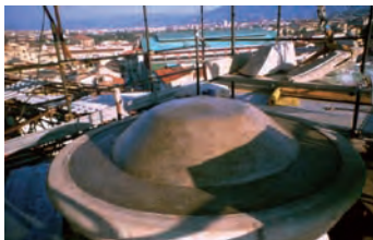
Riassemblaggio della copertura in marmo
