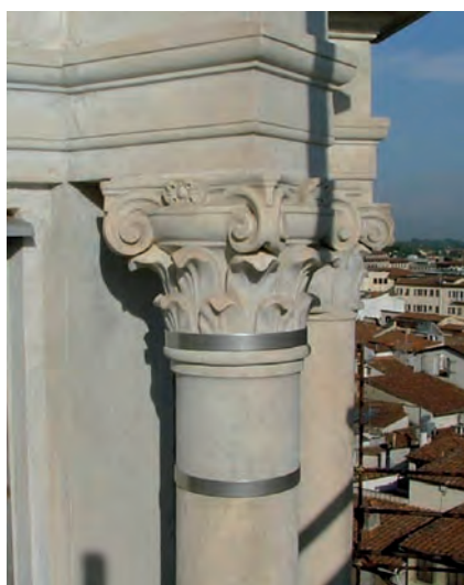
Rimozione dei vecchi interventi di restauro con malta cementizia. Impacco per la rimozione dell'umidità. Ricostruzione delle modanature con malta di calce
