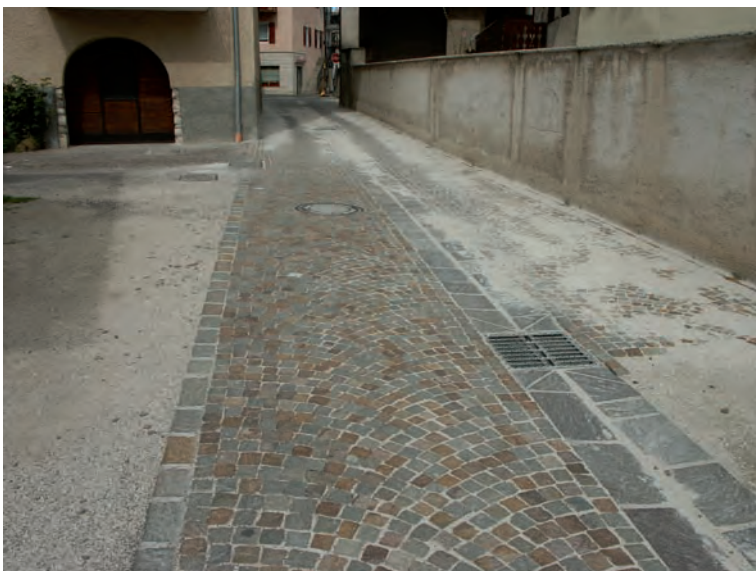
Pavimentazione in cubetti durante la sigillatura in sabbia
