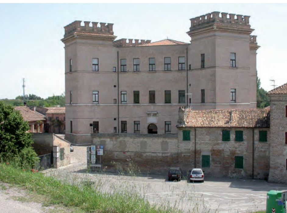
Veduta del castello della Mesola dalla strada lungo l'argine del Po di Goro
