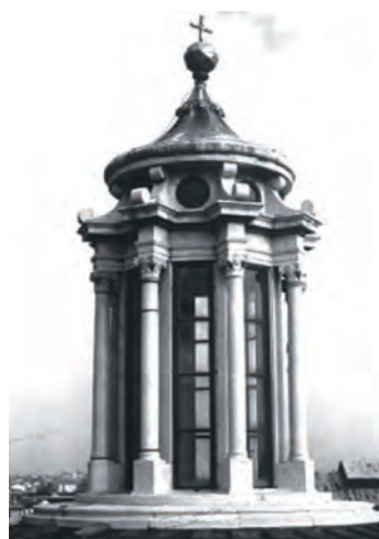
Immagine della lanterna prima dei restauri
