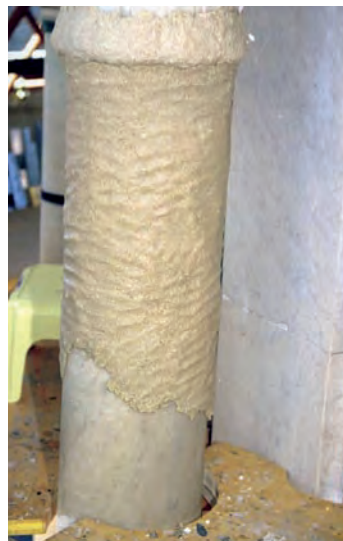
La polverizzazione per vaporizzazione del solo deposito di crosta nera ha permesso una pulitura estremamente puntuale e delicata
