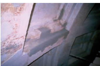
Rimozione dei vecchi interventi di restauro con malta cementizia. Impacco per la rimozione dell'umidità. Ricostruzione delle modanature con malta di calce
