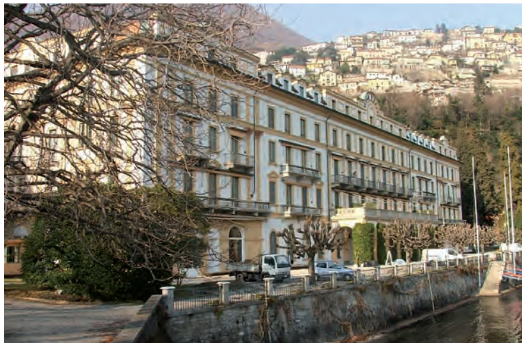
Veduta d'insieme di Villa d'Este dopo l'intervento
