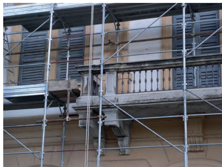
Ripristino degli intonaci durante l'intervento
