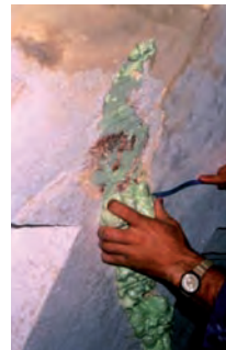
Ricostruzione dell'intonaco mediante rinzaffatura, arriccio e velo finale con grassello di calce e sabbia di lago, lisciato a mestola
