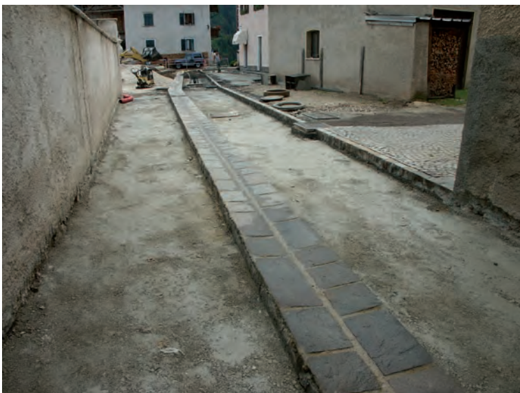
Comune di Romeno (Trento), predisposizione doppia fascia di piastrelle piano cava con coste a spacco
