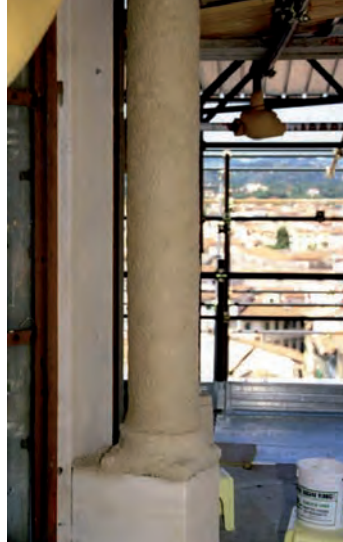
Pulitura con applicazioni d'impacchi a base di pasta cellulosa e sepiolite addizionati con carbonato d'ammonio con percentuale variabile in soluzione acquosa
