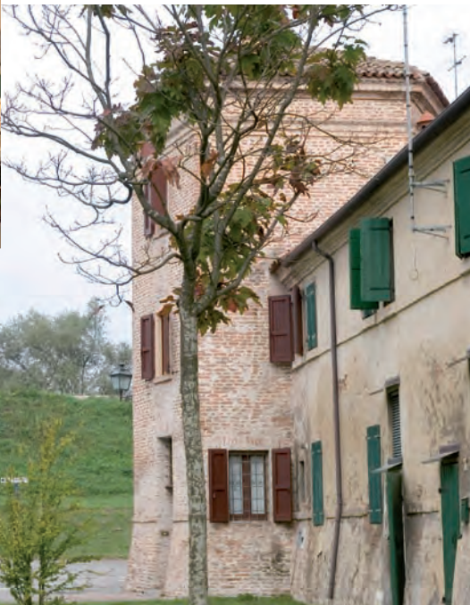
Veduta di una delle torrette d'angolo all'esterno della piazza porticata che circonda il castello
