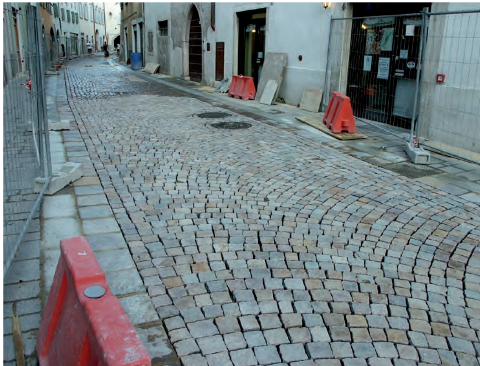
Lavis, via Matteotti - pavimentazione prima della fase di sigillatura
