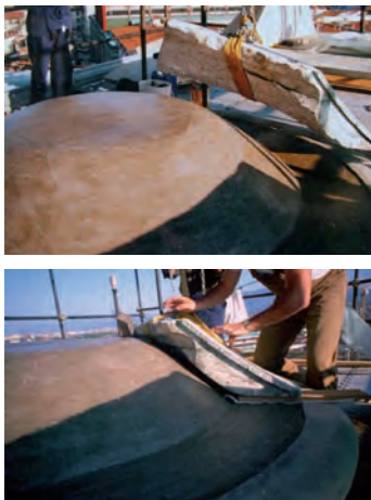
Riassemblaggio della copertura in marmo
