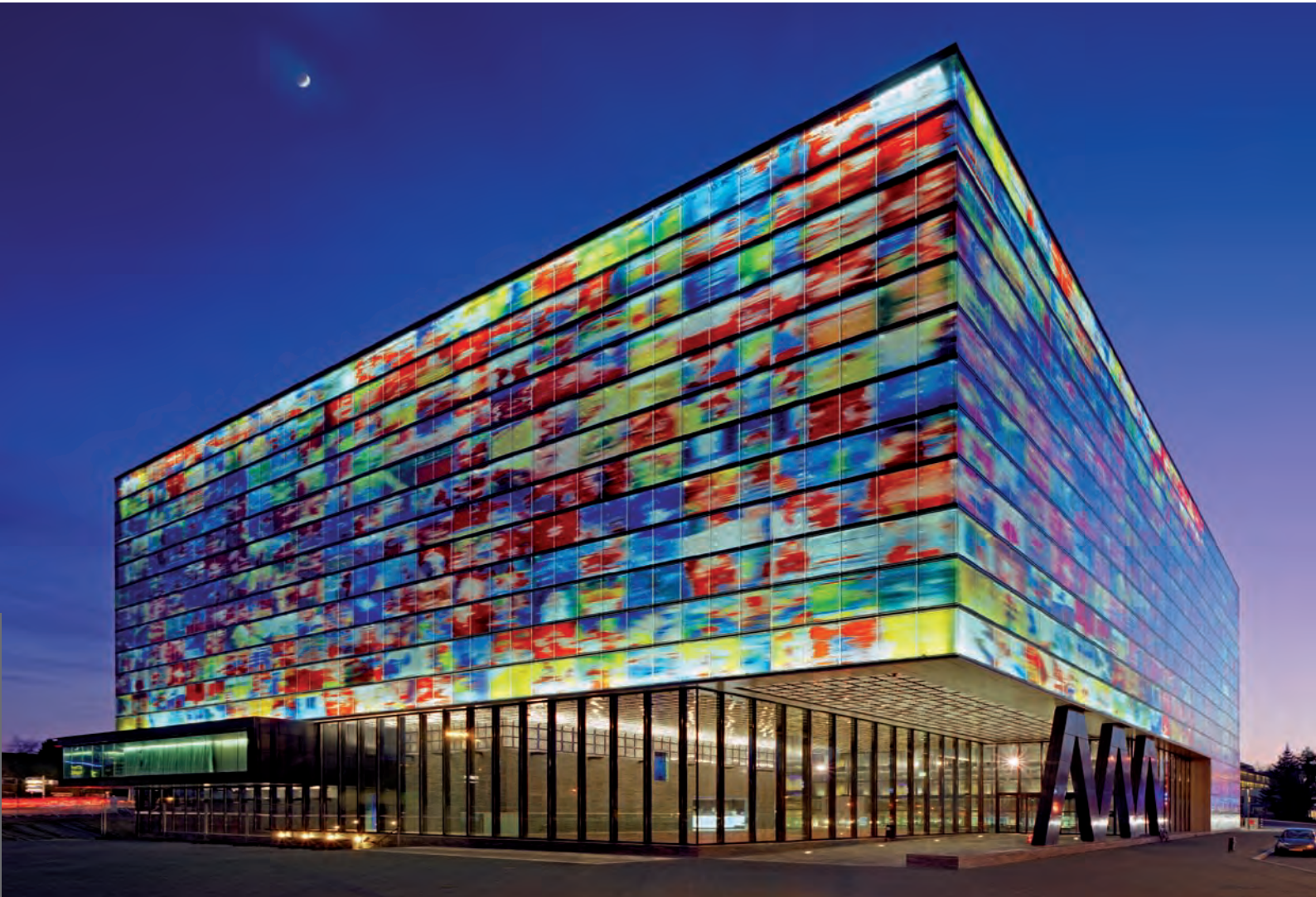
Ingresso principale da nord-est
