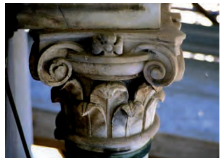
La polverizzazione per vaporizzazione del solo deposito di crosta nera ha permesso una pulitura estremamente puntuale e delicata
