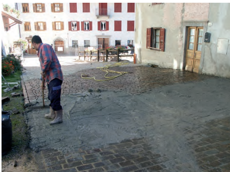
Operazione di sigillatura in boiacca cementizia
