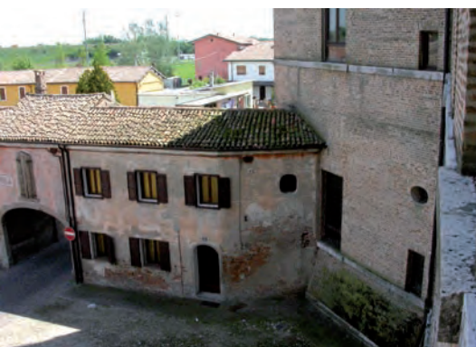
Innesto di uno dei lati dei bassi edifici che circondano la piazza nella mole del castello
