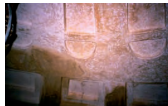
Ricostruzione dell'intonaco mediante rinzaffatura, arriccio e velo finale con grassello di calce e sabbia di lago, lisciato a mestola
