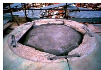
Corrosione dell'impermeabilizzazione in piombo
