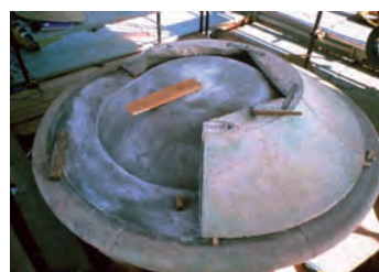
Corrosione dell'impermeabilizzazione in piombo
