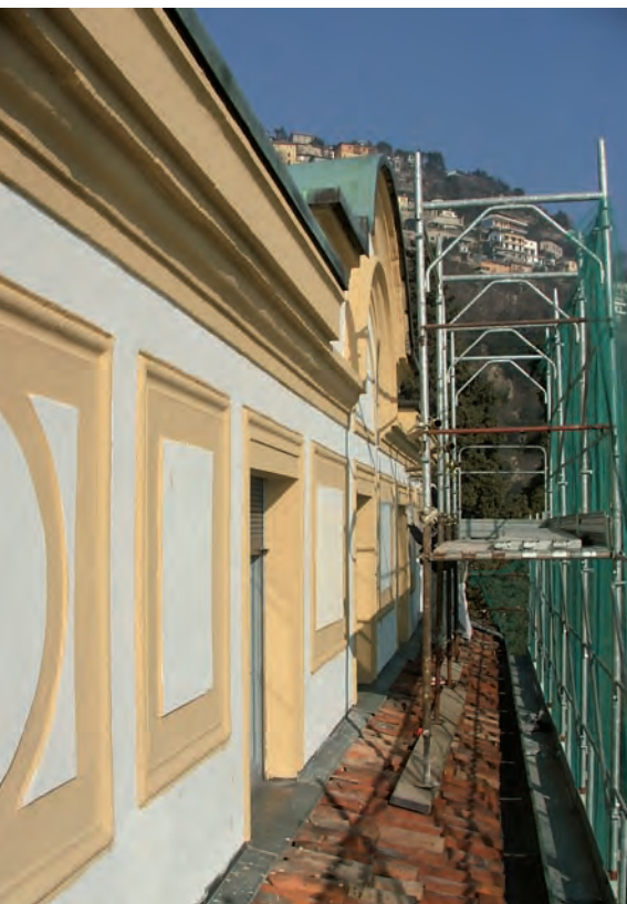
Stesura delle due mani di prodotto K81 al quarzo
