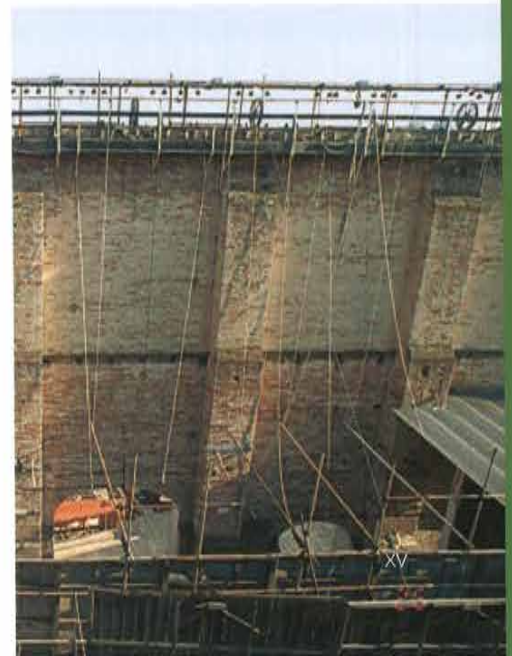
Immagine dei dispositivi sulla sommità dell'alto muro di appoggio, necessari al fissaggio e alla movimentazione delle scenografie allestite in occasione delle manifestazioni che il complesso architettonico ospita
