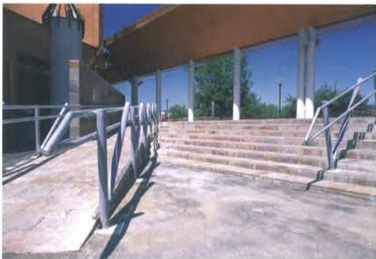
Veduta dell'accesso principale alla stazione tangente alla sede municipale: le rampe inclinate rappresentano le modalità privilegiate di collegamento tra la piazza e la banchina, in piena continuità spaziale e dei percorsi
