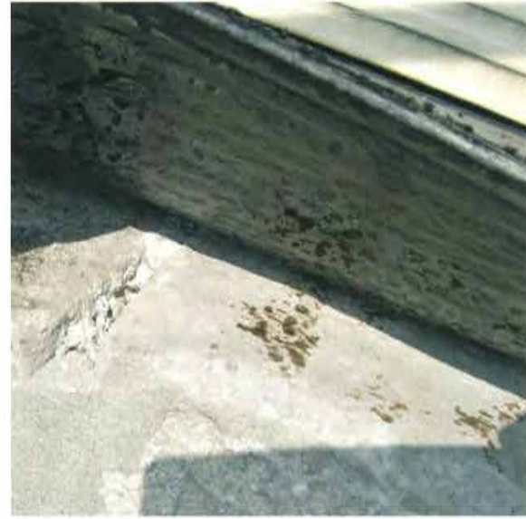
Particolare della barriera al vapore posata sopra la gettata di cemento
