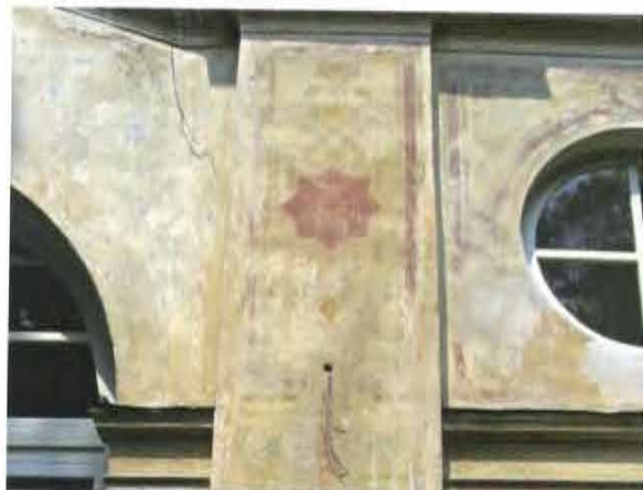
I dettagli della facciata prima dell'intervento
