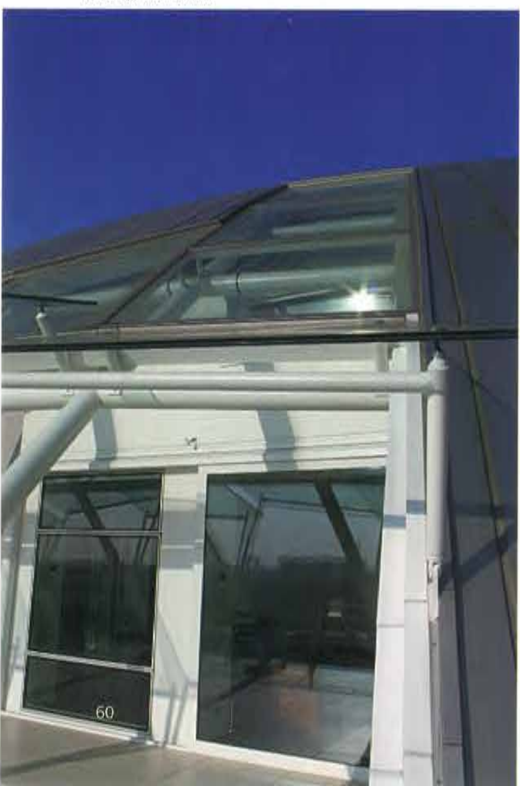
Dettaglio del terrazzo in facciata Foto N. Giacomini
