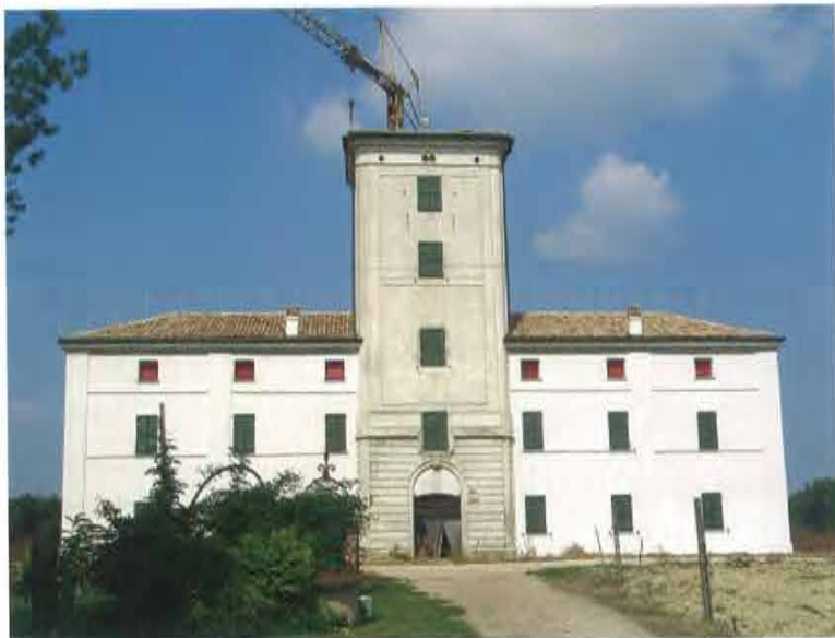
Vista generale del fronte durante una delle fasi conclusive del cantiere. È visibile lo stato di avanzamento dell'intervento sulle murature esterne, concluso nelle fasi di applicazione del rinzafo, dell'intonaco e della rasatura del ciclo di risanamento
