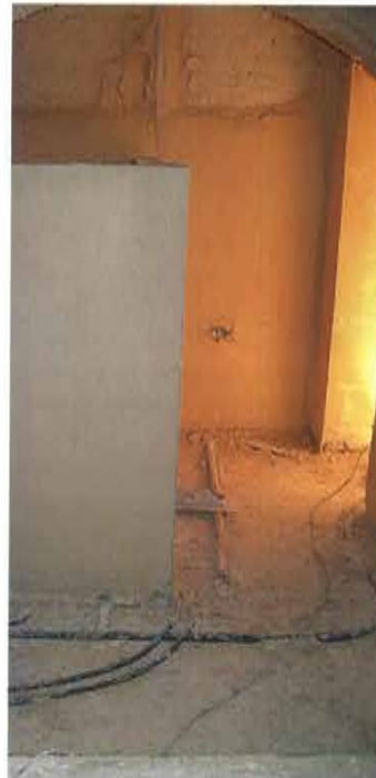
Fasi dell'applicazione dei prodotti della linea bio per il risanamento delle murature. Sopra lo strato di rinforzo risanante è stato utilizzato l'intonaco per il risanamento dalla presenza di umidità. A conclusione del ciclo, è stato applicato lo strato di intonaco di finitura che garantisce un elevato grado di traspirabilità
