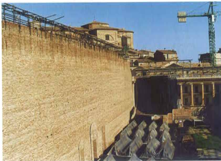
Immagine dei dispositivi sulla sommità dell'alto muro di appoggio, necessari al fissaggio e alla movimentazione delle scenografie allestite in occasione delle manifestazioni che il complesso architettonico ospita
