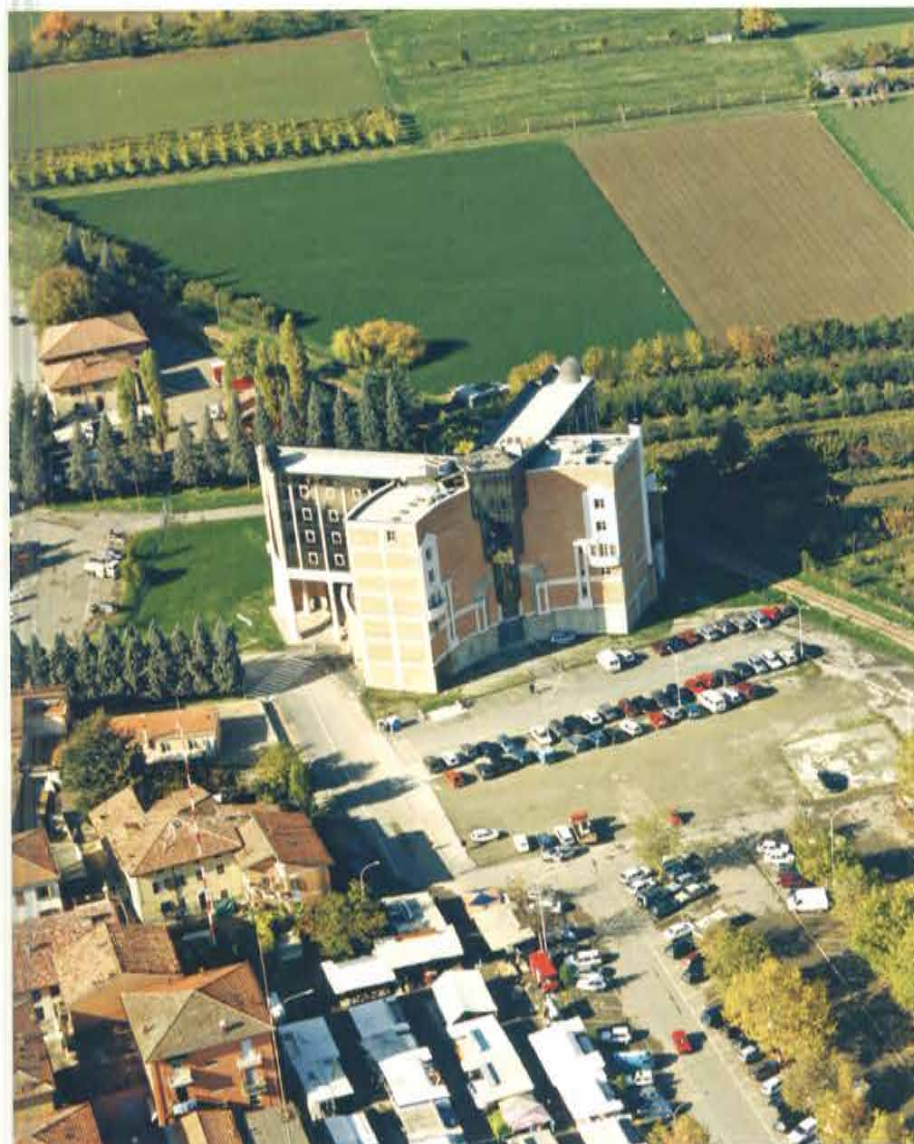
Veduta aerea del municipio, rimasto incompleto, prima degli interventi di trasformazione e completamento
