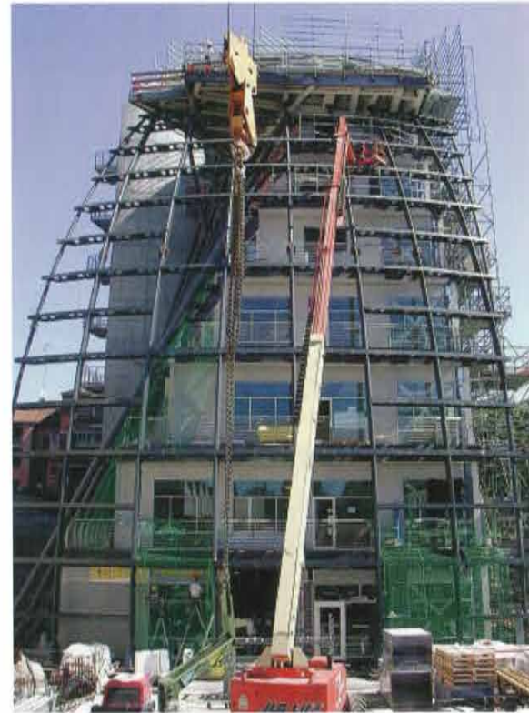
La struttura in cantiere
