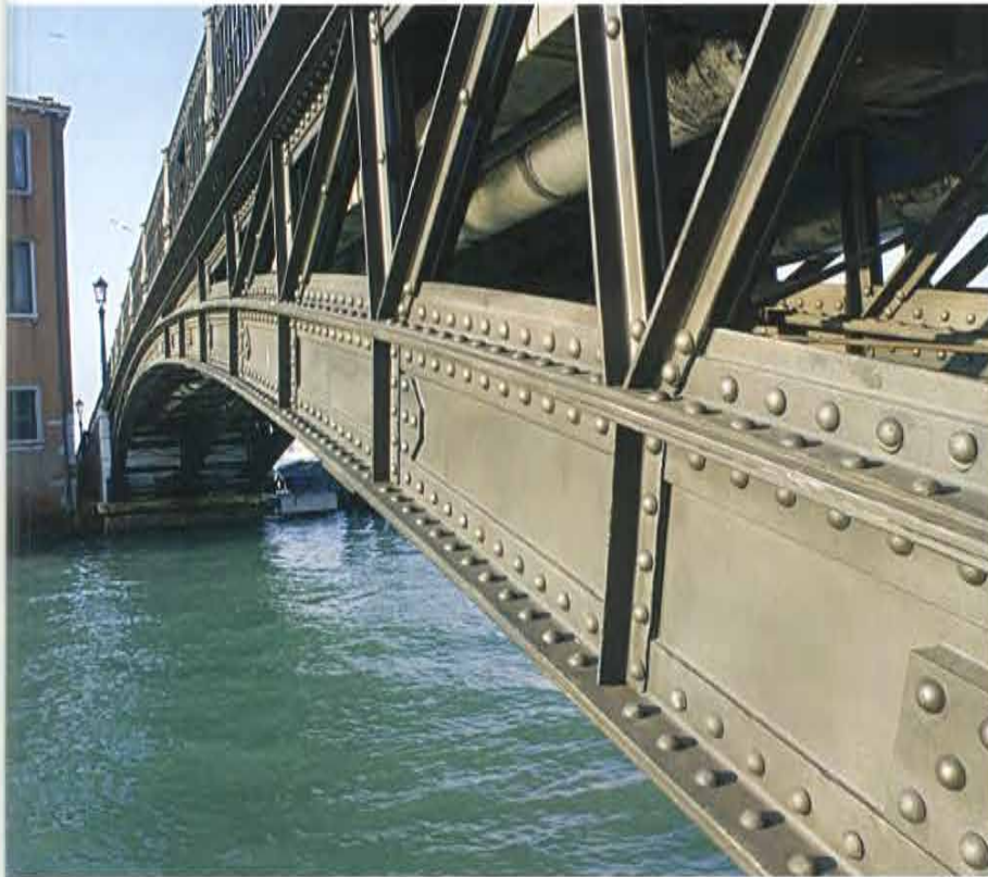
Particolare dell'arcata del ponte a restauro avvenuto. Da notare una piccola parte degli oltre 9000 chiodature installate
