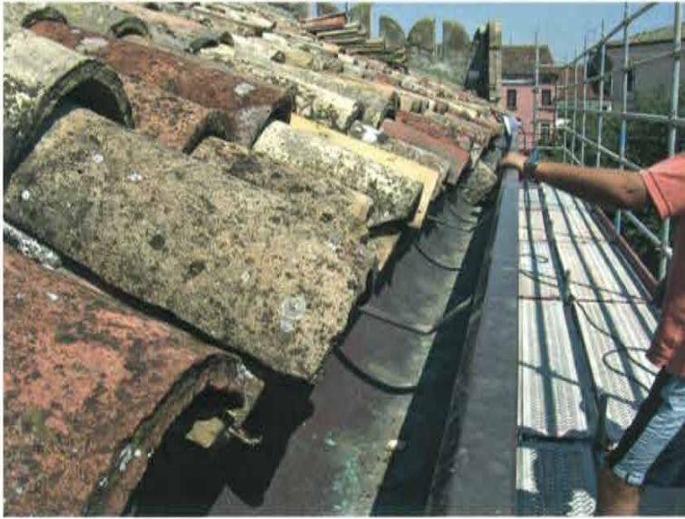
Tetto, vista laterale. I coppi hanno colorazioni differenti a seconda del periodo di fabbricazione, posizione della "linea di gronda" vincolante all'innalzamento del pacchetto di copertura
