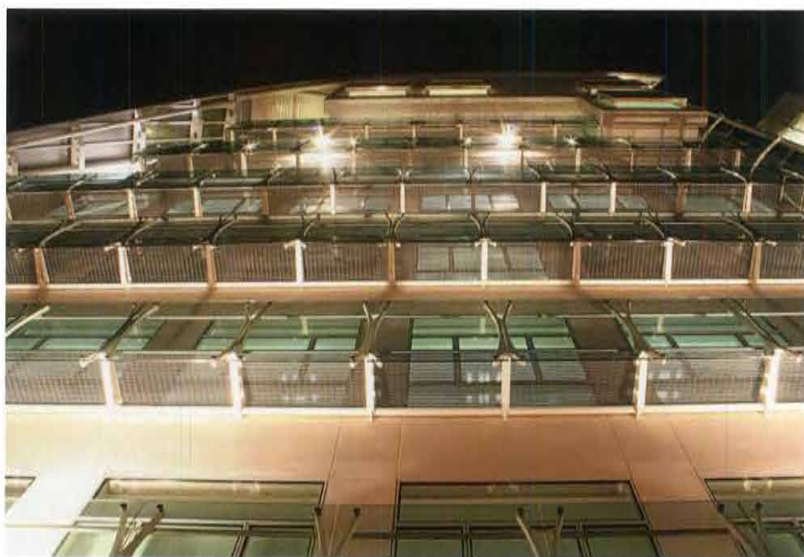
Dettaglio della facciata sud-est. Foto N. Giacomini
