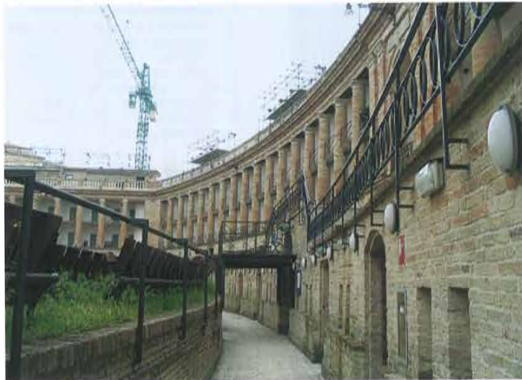
Vista del passaggio di distribuzione lungo la muratura curvilinea che delimita da un lato il grande spazio interno dell'Arena Sferisterio
