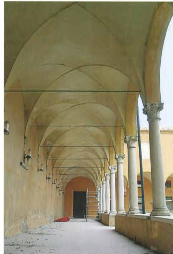
Il lato ovest del chiostro prima dell'inizio dei lavori che, nell'ambito del progetto di restauro, hanno riguardato anche il risanamento delle finiture delle murature storiche
