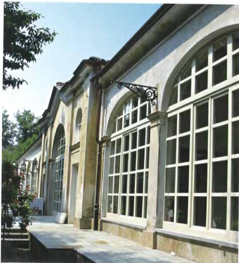
Vista d'insieme prima dell'intervento
