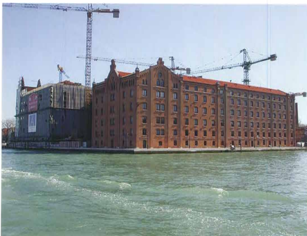
Vista del Molino Stucky
