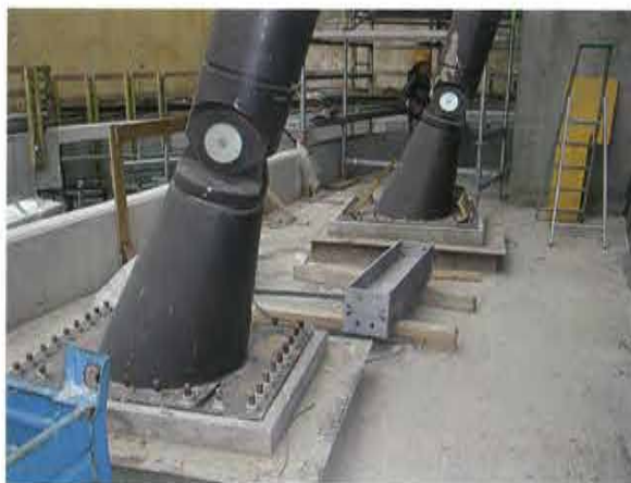
Particolari delle cerniere di appoggio della vela
