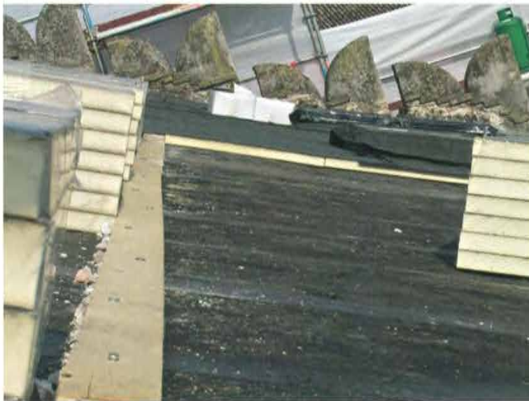
Fissaggio pannelli sopra la barriera al vapore
