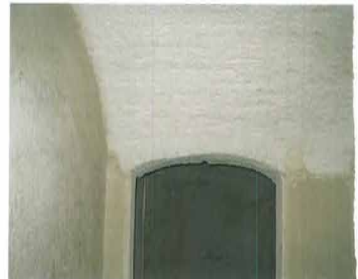
Fasi dell'applicazione dei prodotti della linea bio per il risanamento delle murature. Sopra lo strato di rinforzo risanante è stato utilizzato l'intonaco per il risanamento dalla presenza di umidità. A conclusione del ciclo, è stato applicato lo strato di intonaco di finitura che garantisce un elevato grado di traspirabilità
