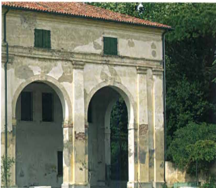
Particolare della zona d'angolo del portico antistante il prospetto sud dell'edificio; nelle due campate visibili nell'immagine, si nota lo stato di degrado delle finiture superficiali, fino alla quota della cornice sottogronda
