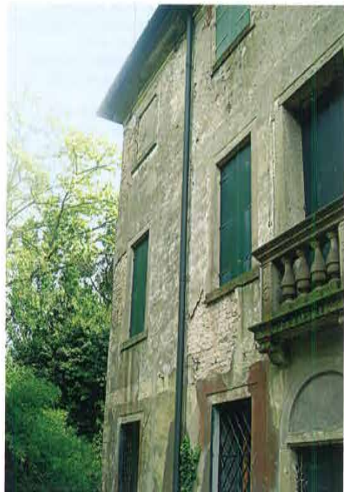
Particolare della facciata nord; sono visibili zone di mancanza e sollevamento dell'intonaco e la presenza di lacerti di diversi strati di coloritura
