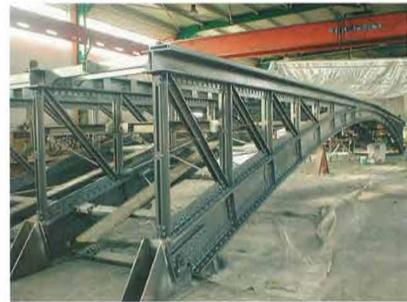
Le arcate in officina completamente restaurate pronte per il trasporto al sito
