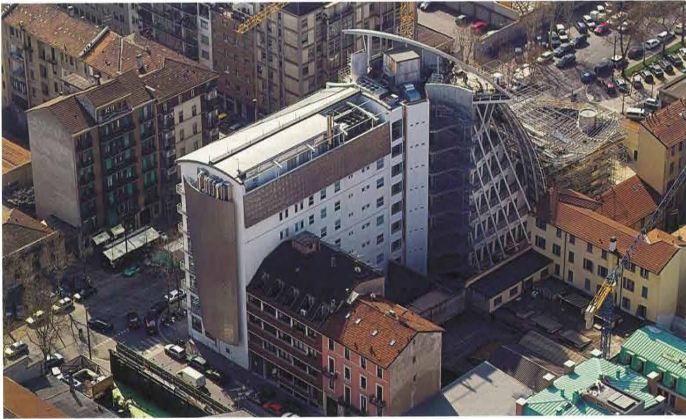
Ripresa aerea del cantiere
