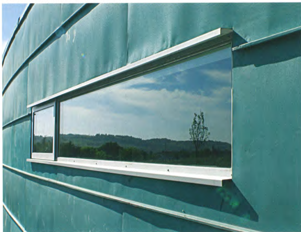
Particolare del rivestimento in rame patinato
