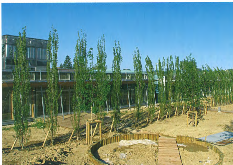
La facciata sud protetta da vegetazione cedua
