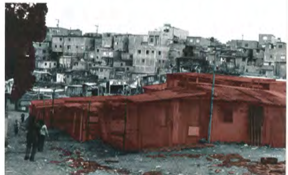
Confini molli: alberi abbattuti, nuove baracche, una discarica abusiva in espansione
