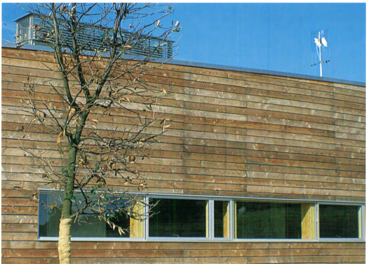
Particolare del rivestimento in legno del prospetto nord
