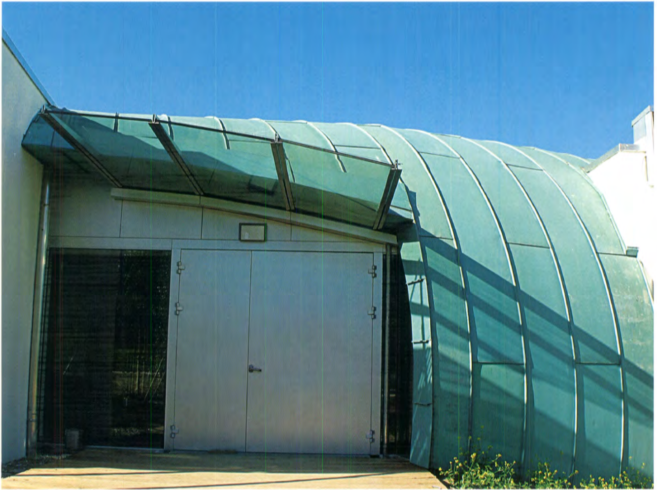
L'ingresso alla scuola
