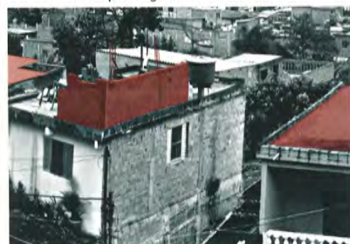
La costruzione degli edifici avviene secondo fasi successive
