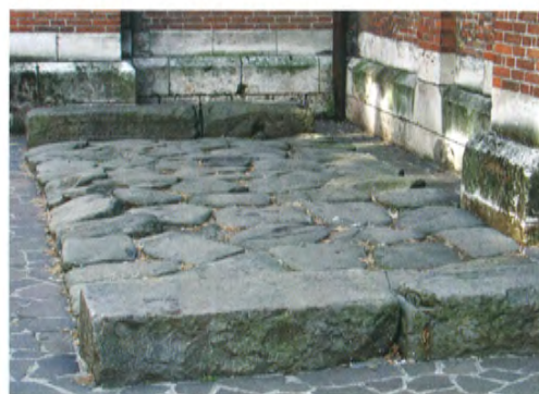
Antica strada romana nel centro storico di Vicenza realizzata con basoli di trachite grigia classica di Montemerlo
