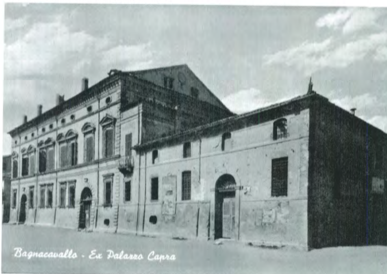
Le trasformazioni del paesaggio urbano: via Matteotti. Veduta 1940 e 2006 (Archivio L. Betti)
