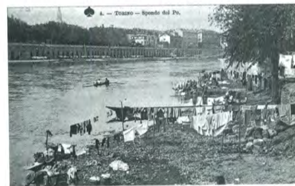
Lavaggio dei panni: "le lavandaie esercitavano la più diffusa delle attività lavorative del fiume. La cartolina illustra la parte del fiume di fronte ai Murazzi dove erano insediate le fabbriche. Nonostante la presenza di queste le lavandaie lavorano anche qui e lasciano i panni stesi ad asciugare sulla riva adiacente"
