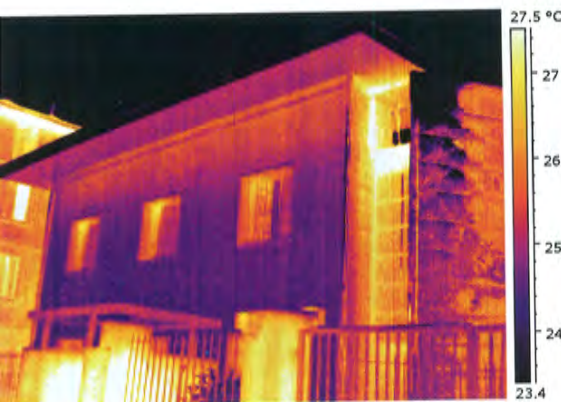
L'edificio, grazie all'impiego di materiali isolanti ed alla progettazione di una parete ventilata, non presenta ponti termici
