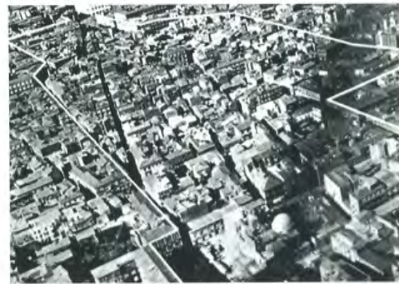
Il perimetro della demolizione del quartiere
