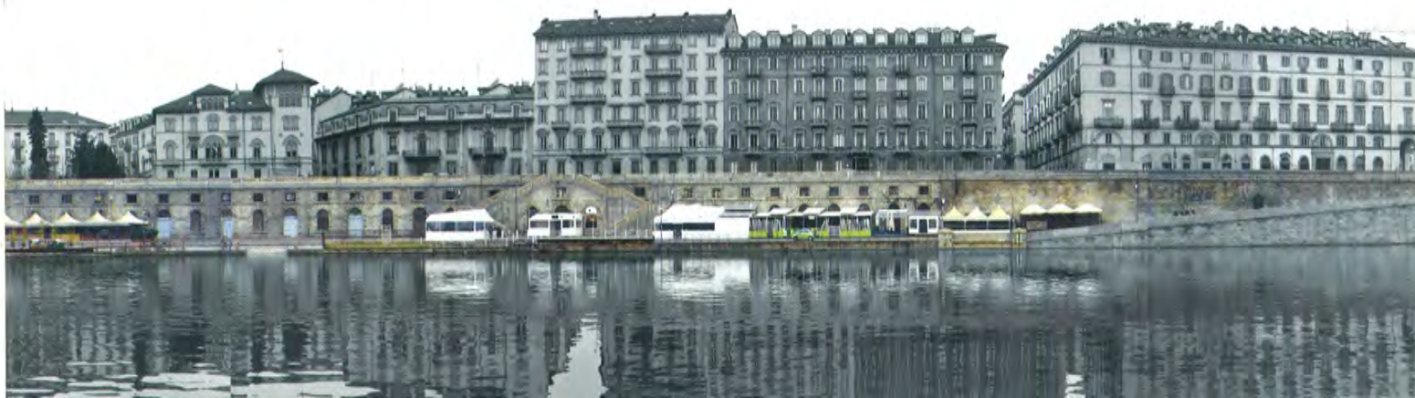
Vista generale del Complesso dei Murazzi dalla sponda destra del fiume Po
