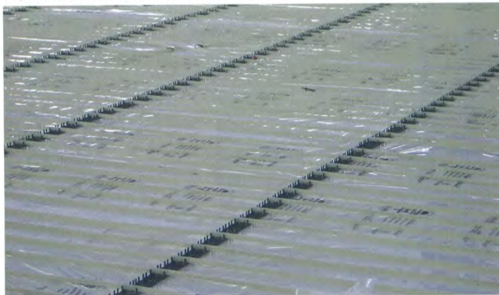
L'impianto radiante a pavimento Modulplus di EHT
