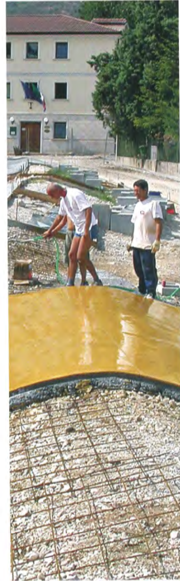
Dettaglio della fase di realizzazione della superficie Foto E. Crovato
