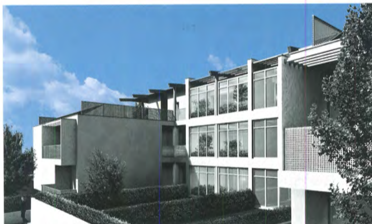
Corte interna. Due ingressi pedonali distribuiscono l'afflusso ai corpi scala interni secondo un disegno planimetricamente simmetrico degli interni. Il volume arretrato che funge da elemento d'unione tra i due corpi laterali è costituito da logge vetrate continue
