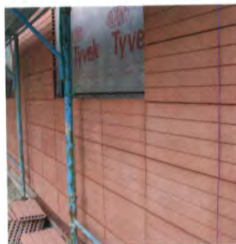
Rivestimento con facciata ventilata in cotto
