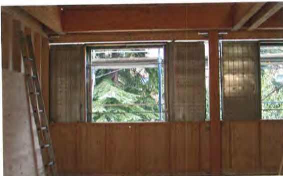
I serramenti esterni sono realizzati con il sistema a scomparsa "Duo"; il serramento esterno in legno a stecca aperta e la grata antieffrazione sono a scomparsa, mentre il serramento interno in legno e vetro è a doppia anta con sistema dry-kit
