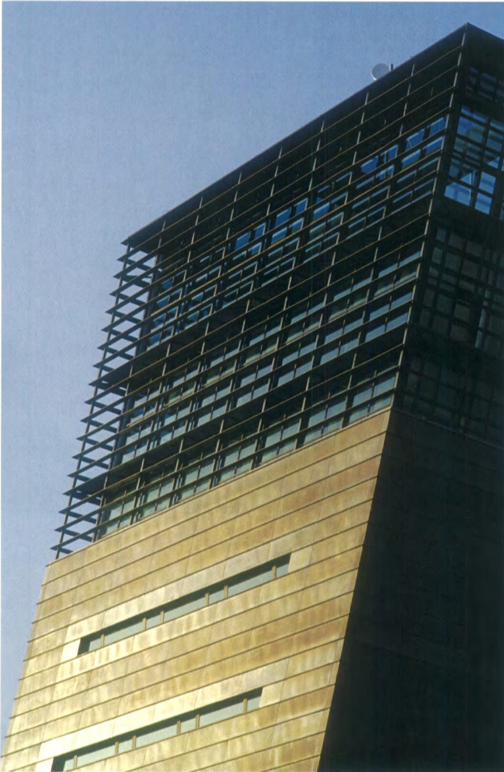
Dettaglio della parte terminale della torre
