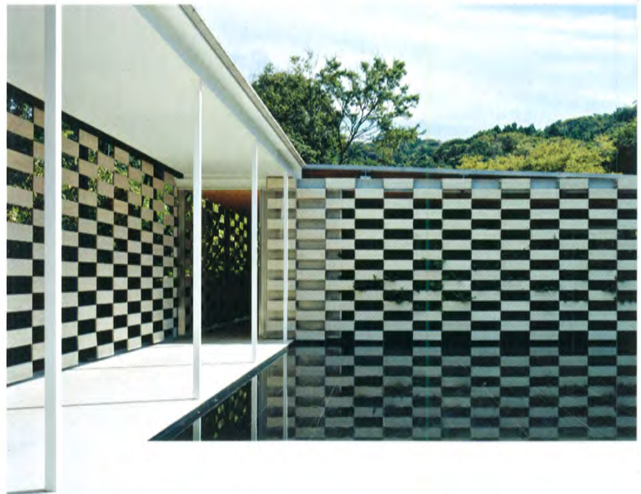
Dettaglio della facciata: la trama delle lastre in travertino su telaio di acciaio
