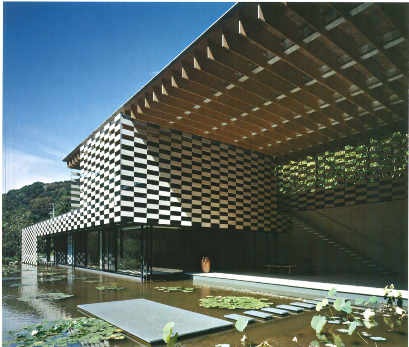
Il tetto terrazzo verso il fronte ovest
