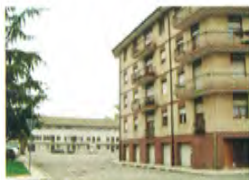
edificio in posizione contrastante
