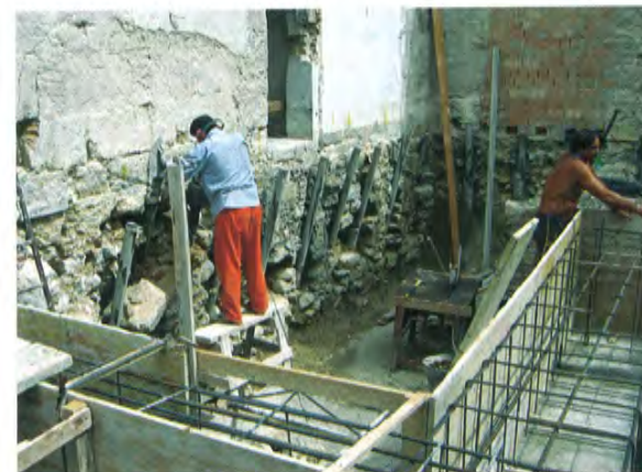
Particolare della realizzazione dei rinforzi delle fondazioni esistenti con micropali e cordoli in c.a.
