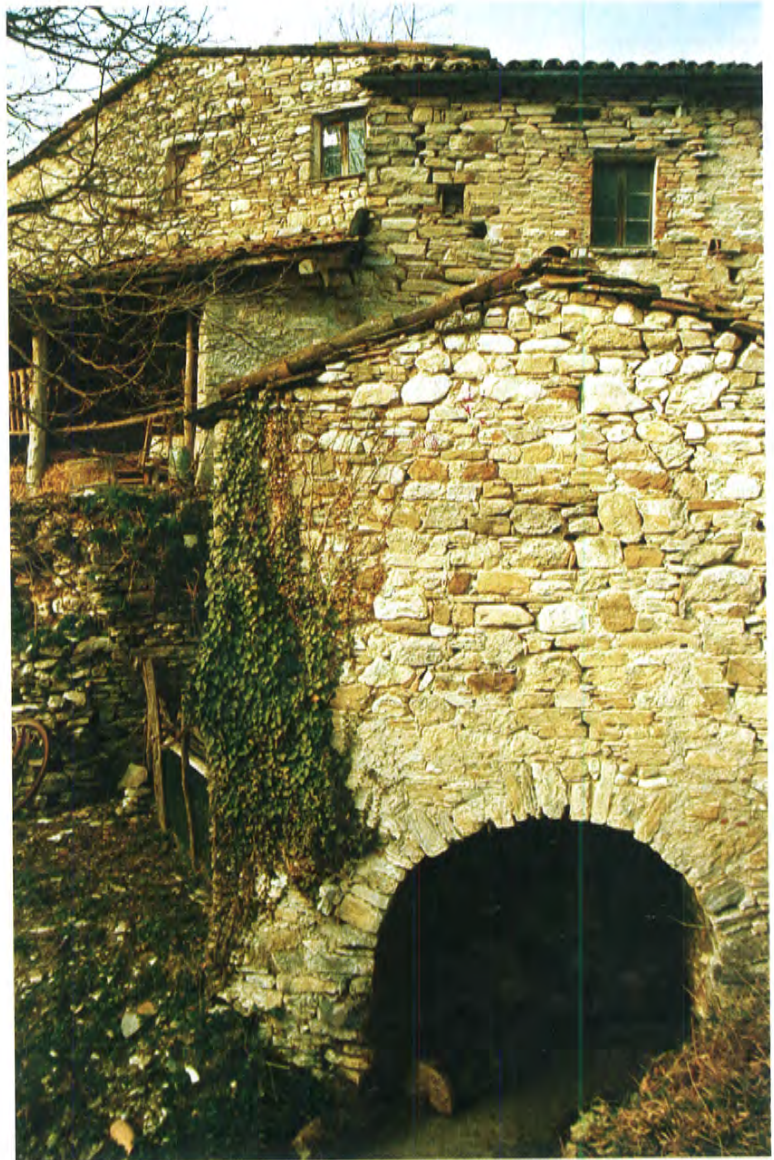
Mulino del Bosco situato in una zona montana (Comune di Monte Copiolo), come si può dedurre dai materiali utilizzati per la sua costruzione: completa assenza di mattoni e soprattutto l'utilizzo delle lastre di pietra per la realizzazione del manto di copertura, del quale rimane solo una piccola traccia, essendo stato sostituito con laterizi. Questo opificio ha come caratteristica la presenza di un doppio apparato idraulico disposto a caduta in serie alimentato da un unico canale
