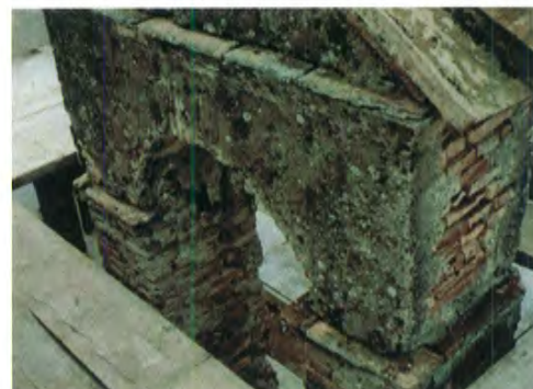
Vista della sommità del campanile durante i lavori di restauro; si intuisce la consistenza ed il degrado delle malte
