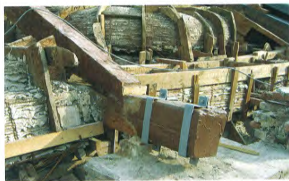
Dettaglio del restauro di un appoggio della capriata con acciaio e resine
