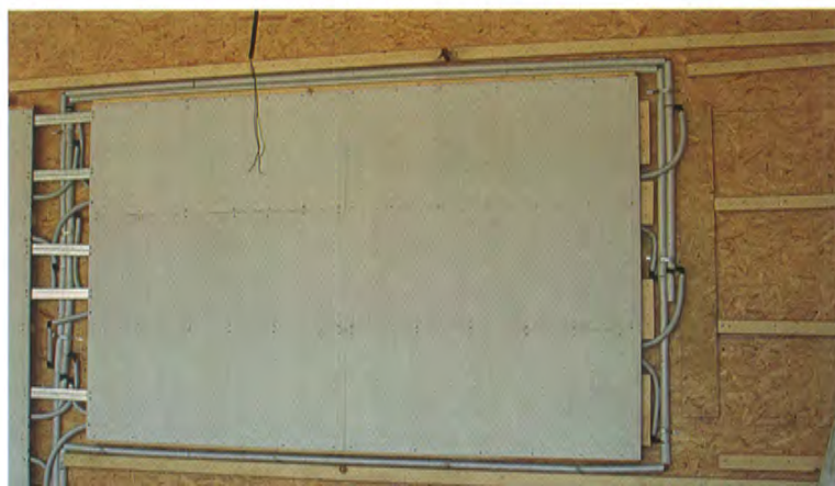
Sistema di pannelli radianti a parete a bassa temperatura in fase di esecuzione su divisorio a secco: i pannelli hanno la funzione di riscaldare e raffrescare gli ambienti interni
