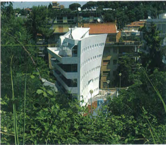
La palazzina vista dalle colline
