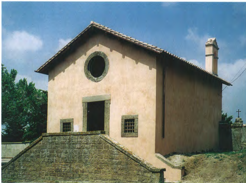
Vista dei fronti esterni della chiesa dopo i restauri
