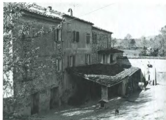
Il Mulino Leardini di Sopra prima e dopo la ristrutturazione
