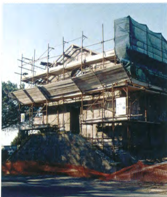
Vista complessiva del cantiere di restauro
