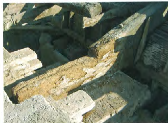
Particolare di un appoggio della capriata prima del restauro
