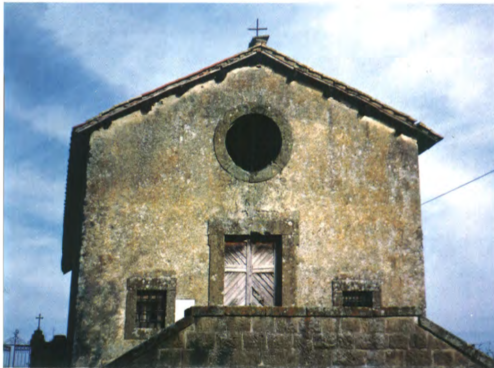
La facciata principale prima del restauro
