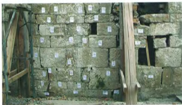
Particolare del muro antico durante la fase di numerazione dei conci per il successivo riassetto
