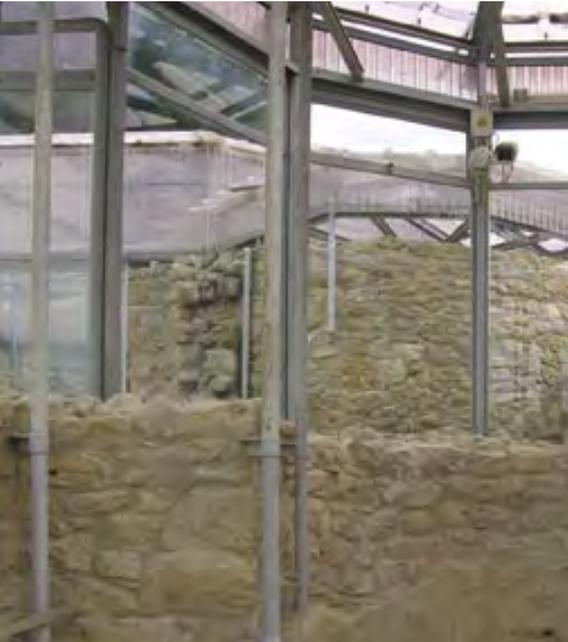
*Vista interna con la struttura di copertura ancorata tramite tubolari metallici alla muratura di sacrificio realizzata sopra ai ruderi*
