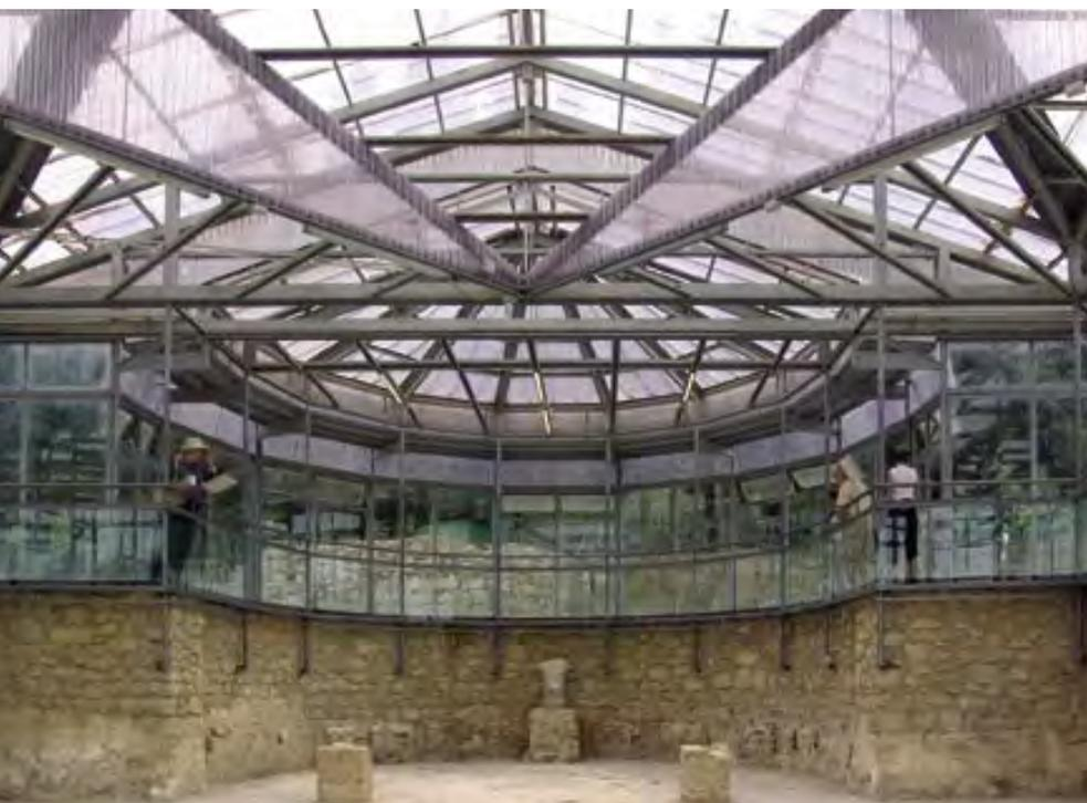
*La grande sala triloba con vista delle passerelle soprastanti da cui è possibile osservare i mosaici pavimentali raffiguranti il trionfo di Ercole. Le passerelle sono ancorate tramite tubolari metallici alla muratura di sacrificio realizzata sopra ai resti delle strutture murarie antiche*
