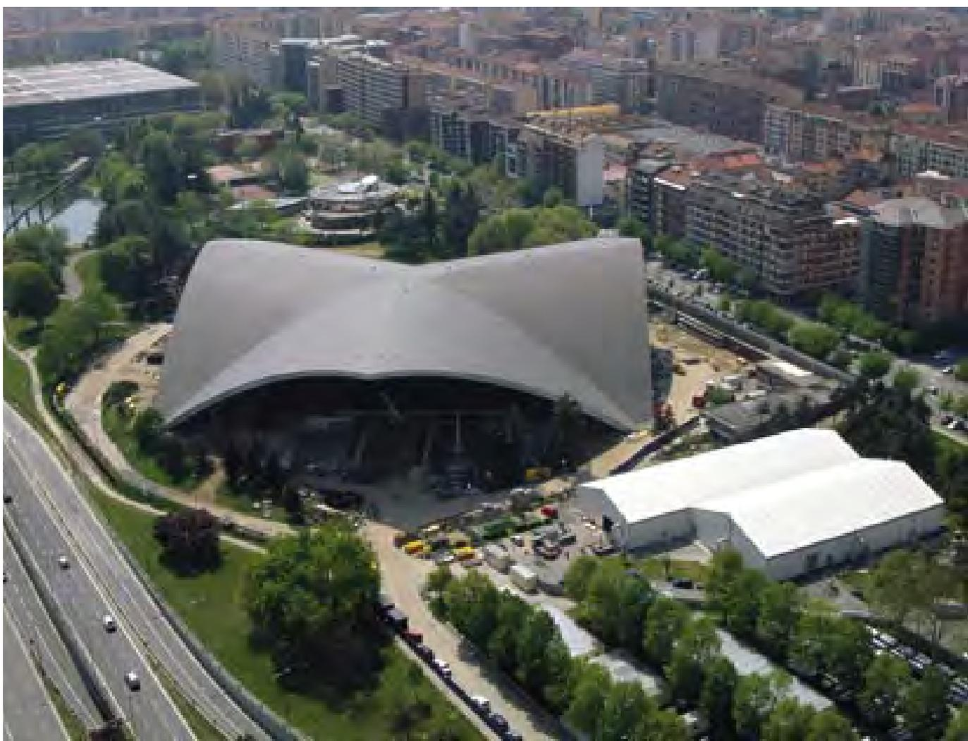
hanno scelto di realizzare un "edificio nell'edificio", con proprie caratteristiche formali, indipendente strutturalmente dalla volta esistente, ma che ne rispettasse il disegno, la geometria e la sua unitarietà. Sia per la pavimentazione interna che per quella esterna, per una superficie complessiva di circa 16.000 mq, sono state utilizzate lastre di Ardesia Bordeaux high-tech in ceramica tecnica di produzione Ariostea.
