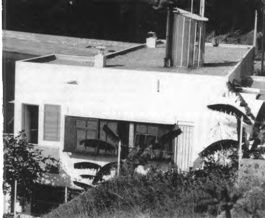
E1027 - facciata est. Si nota il vano scala vetrato che emerge dal tetto e il particolare sistema di oscuramento delle finestre
