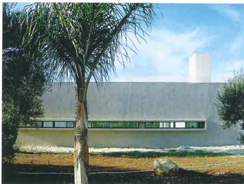
Il muro esterno della zona giorno inciso dal taglio orizzontale del serramento
