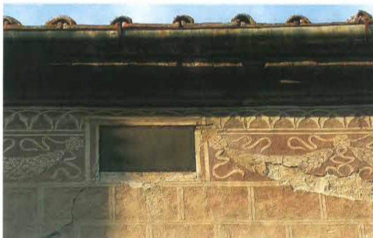
Particolari della finitura della facciata di un edificio del centro storico di Pienza, in provincia di Siena. L'apparecchiatura muraria è celata dall'intonaco dipinto allo scopo di surrogare un paramento in materiale lapideo
