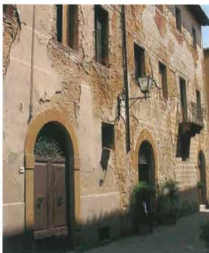
Veduta complessiva e particolari di una facciata del centro storico di Pienza. La piccola città è ancora riccamente adornata da paramenti lapidei simulati, in forma di lacerto sui fronti dell'edilizia minore e in superfici integre e molto ben conservate nell'edilizia storica monumentale dei palazzi signorili. In questo caso è possibile vedere come, oltre all'intonaco dipinto per surrogare un paramento lapideo, siano presenti decorazioni quali uno stemma o la parasta dipinta nell'angolo dell'edificio
