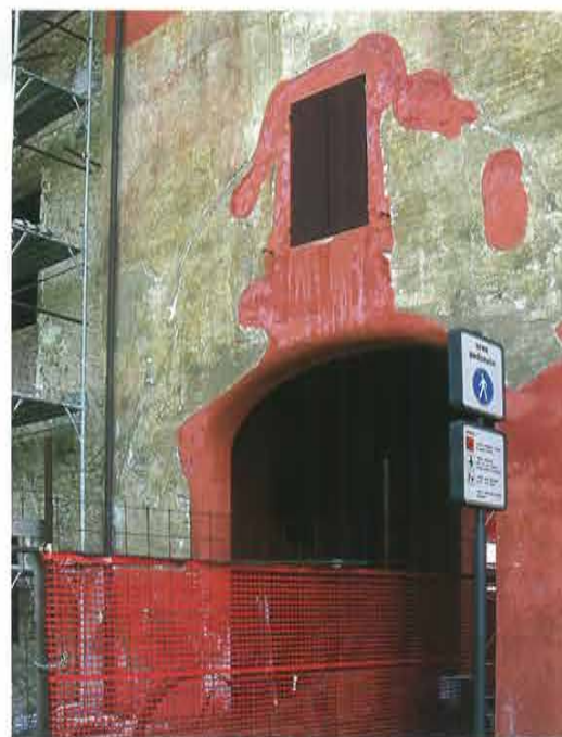
Immagine della situazione attuale del prospetto in cui il passaggio voltato conduce alla strada interna
