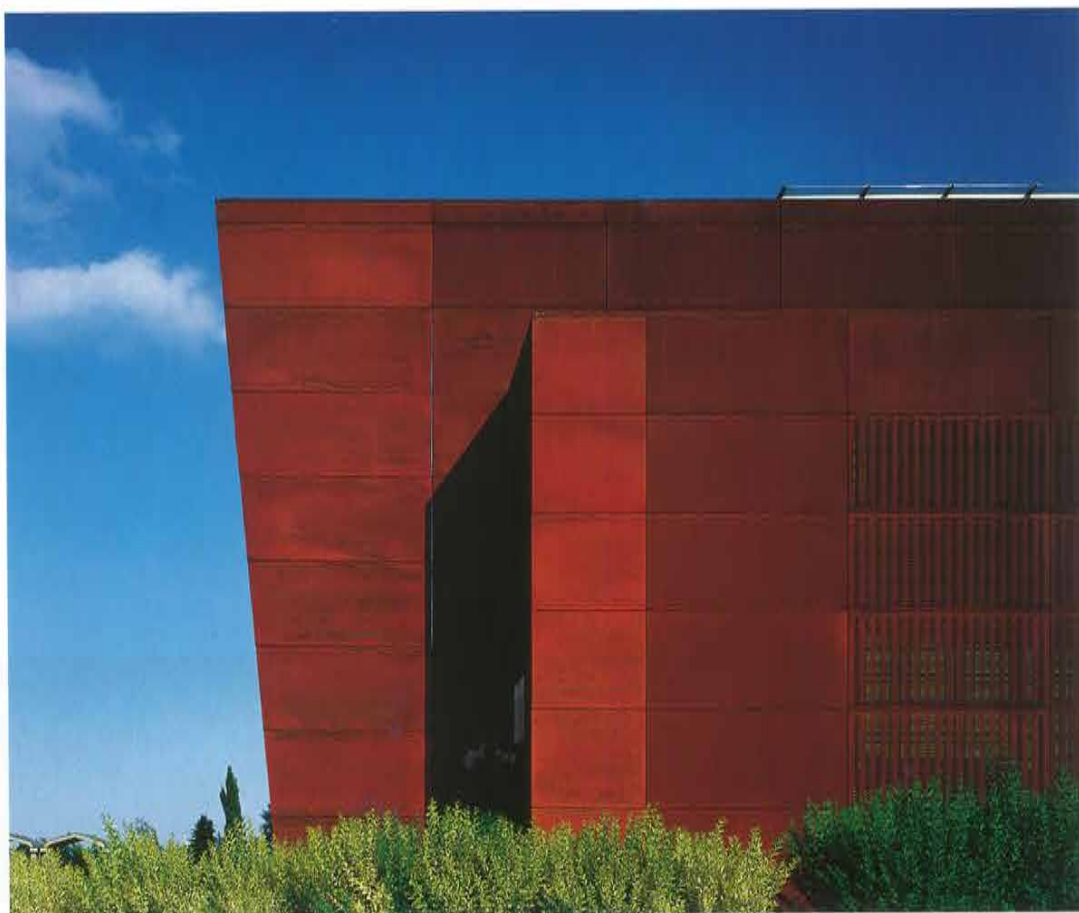
Dettaglio della parete in corten
