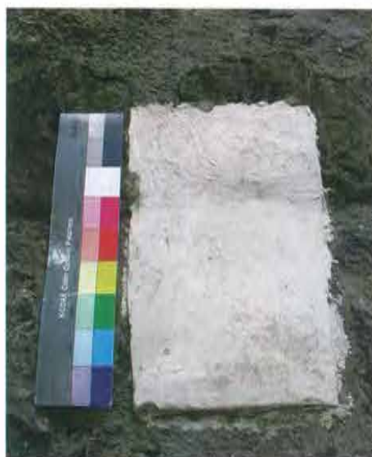
Particolare del campionamento di una malta di restauro realizzato sul paramento di una muratura di contenimento del terrapieno retrostante le facciate delle botteghe. Tali murature sono state realizzate a partire dal primo decennio del XX secolo, successivamente alle fasi di scavo, utilizzando materiali lapidei di reimpiego legati con malte a base idraulica, probabilmente cementizia
