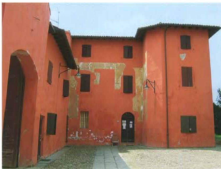
Immagine del risultato dell'intervento eseguito sui fronti esterni del borgo di Colle Ameno. Sono evidenti i lacerti dell'intonaco decorato "sospesi" nell'uniformità dello strato di coloritura (foto M. Barone e F. Fontana, 2004)
