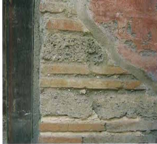
Particolare della muratura mista, in materiale lapideo e laterizio, del fronte dell'officina coattiliaria o bottega dei feltrai, in cui è inoltre visibile un lacerto di intonaco dipinto, il cui spessore evidenzia l'antica tecnica di esecuzione delle finiture mediante l'applicazione di numerosi strati
