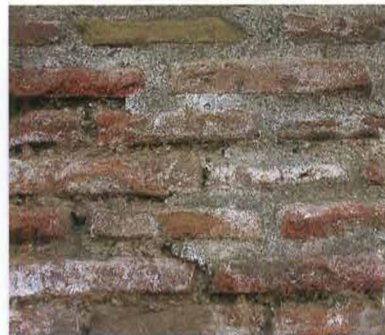
Particolare di uno dei degradi più frequenti e dannosi cui sono soggetti i fronti delle botteghe: i cicli secco-umido favoriscono la fuoriuscita di sali dalle murature, a loro volta soggette al fenomeno dell'umidità di risalita
