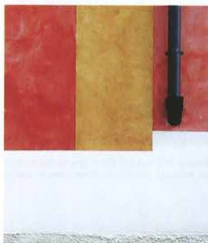
Particolare della fascia basamentale del prospetto ovest. Oltre all'effetto cromatico è visibile il trattamento superficiale con la tecnica della spugnatura
