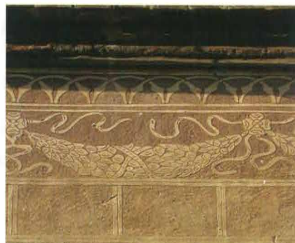
Particolari della finitura della facciata di un edificio del centro storico di Pienza, in provincia di Siena. L'apparecchiatura muraria è celata dall'intonaco dipinto allo scopo di surrogare un paramento in materiale lapideo
