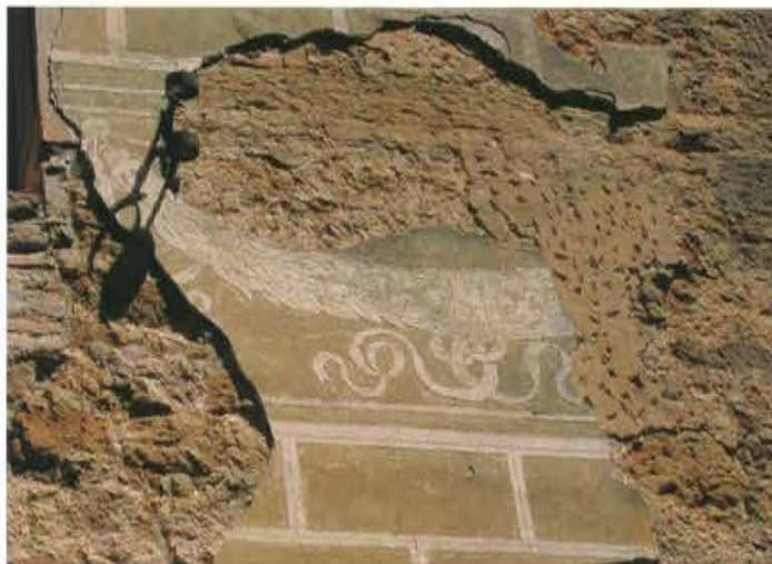
Veduta complessiva e particolari di una facciata del centro storico di Pienza. La piccola città è ancora riccamente adornata da paramenti lapidei simulati, in forma di lacerto sui fronti dell'edilizia minore e in superfici integre e molto ben conservate nell'edilizia storica monumentale dei palazzi signorili. In questo caso è possibile vedere come, oltre all'intonaco dipinto per surrogare un paramento lapideo, siano presenti decorazioni quali uno stemma o la parasta dipinta nell'angolo dell'edificio
