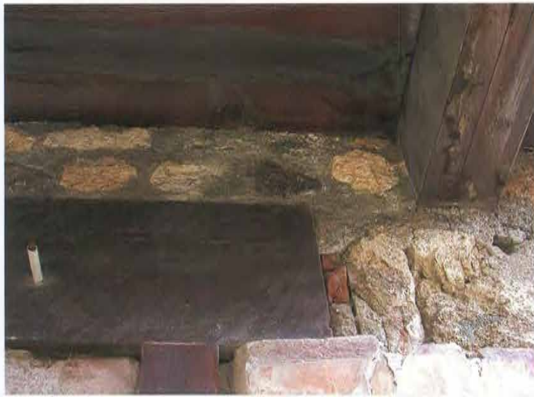
Particolare di uno dei degradi più frequenti e dannosi cui sono soggetti i fronti delle botteghe: i cicli secco-umido favoriscono la fuoriuscita di sali dalle murature, a loro volta soggette al fenomeno dell'umidità di risalita
