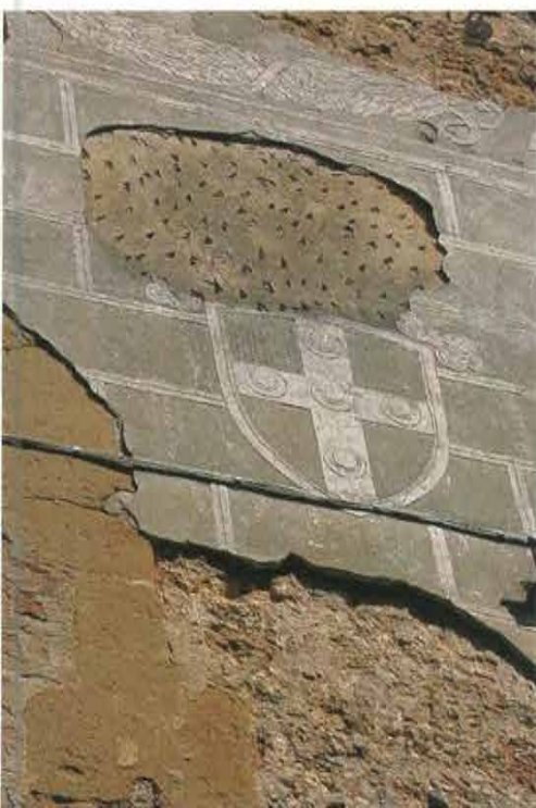
Veduta complessiva e particolari di una facciata del centro storico di Pienza. La piccola città è ancora riccamente adornata da paramenti lapidei simulati, in forma di lacerto sui fronti dell'edilizia minore e in superfici integre e molto ben conservate nell'edilizia storica monumentale dei palazzi signorili. In questo caso è possibile vedere come, oltre all'intonaco dipinto per surrogare un paramento lapideo, siano presenti decorazioni quali uno stemma o la parasta dipinta nell'angolo dell'edificio
