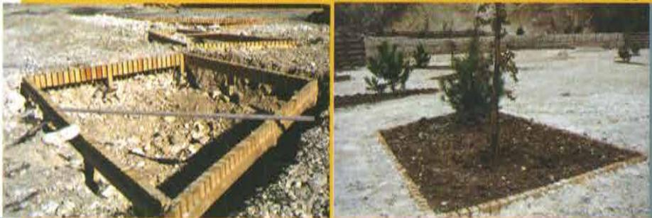
Sezione e viste delle microstrutture di arginamento a pali usate per il contenimento dei volumi di rinterro sulle gradonate della cava Castello Cieco 2
