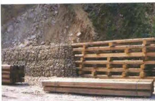
Innesto tra il muro di pietrame a secco ingabbiato e la struttura di arginamento in legno nella cava Castello Cieco 2
