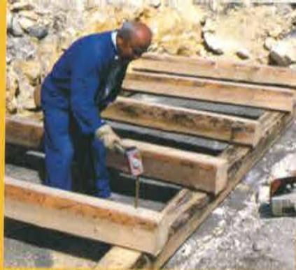
Fasi iniziali di chiodatura degli assi delle strutture di arginamento in legno
