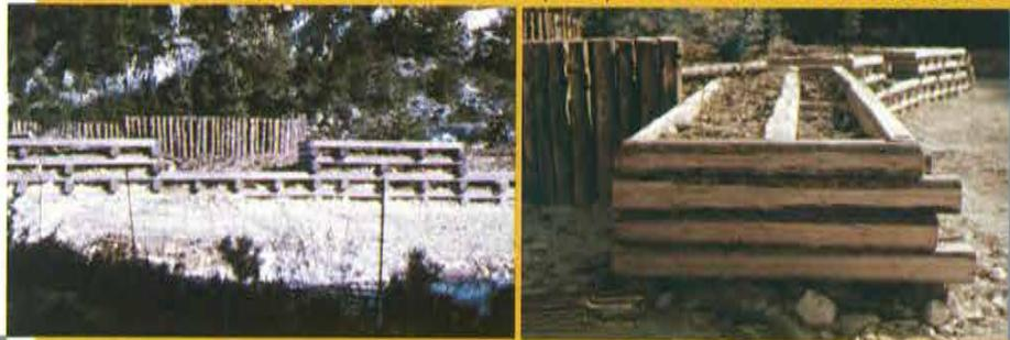
Prospetto del muro a secco ingabbiato di arginamento (innesto con le strutture in legno nella cava Castello Cieco 2). Viste dei muri nella cava Castello Cieco 1
