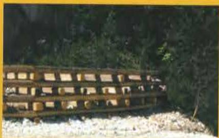
Fissaggio dell'argine con zavorre di pietrame. L'opera è successivamente completata con un interro parziale di terreno vegetale
