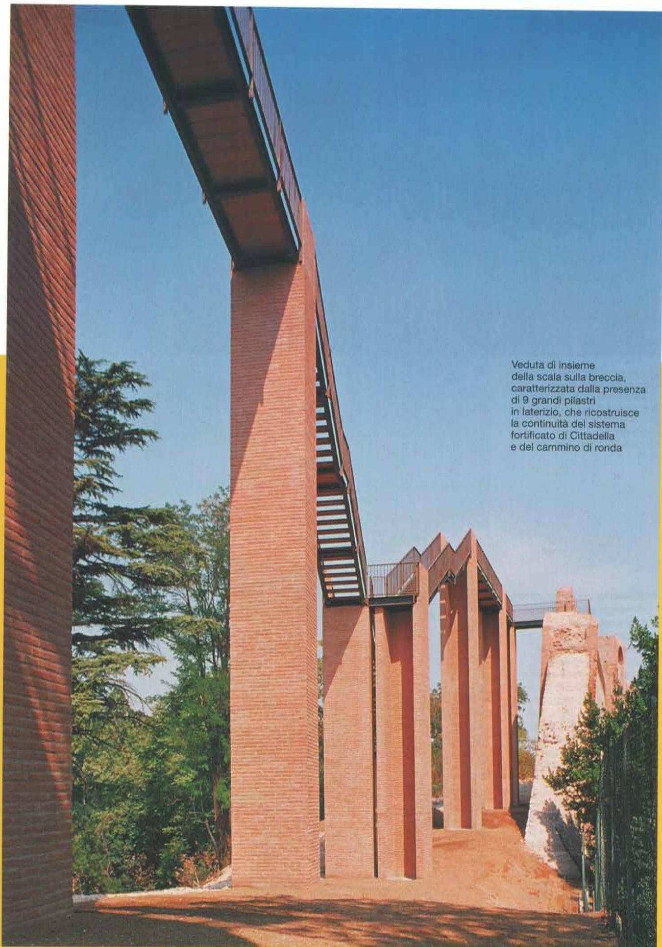
Veduta di insieme della scala sulla breccia, caratterizzata dalla presenza di 9 grandi pilastri in laterizio, che ricostruisce la continuità del sistema fortificato di Cittadella e del cammino di ronda
