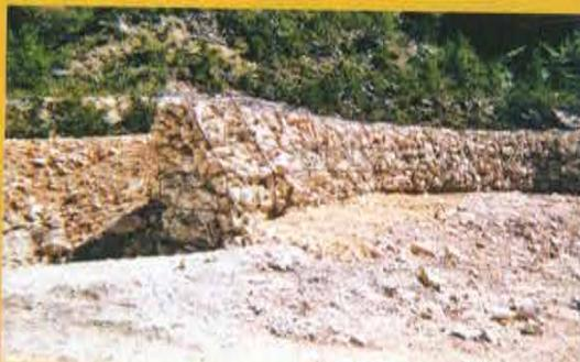
Un muro a secco ingabbiato all'inizio delle opere di riempimento delle aree da rinaturalizzare
