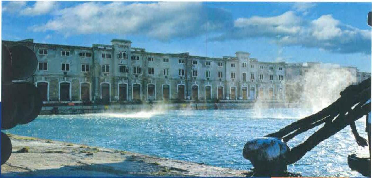
Il piano di banchina
