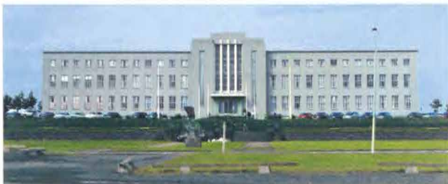
G. Samúelsson, Edificio principale dell'Università, Reykjavik
