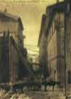
Un esempio di recupero dell'edificio posto in via Francesco Biondini. La ricostruzione dell'edificio è stata completata nel 2004 e ha permesso di recuperare il valore storico e culturale dell'edificio.
