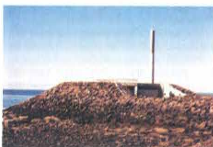
Stazioni di pompaggio a Laugalækur e a Faxaskjól
