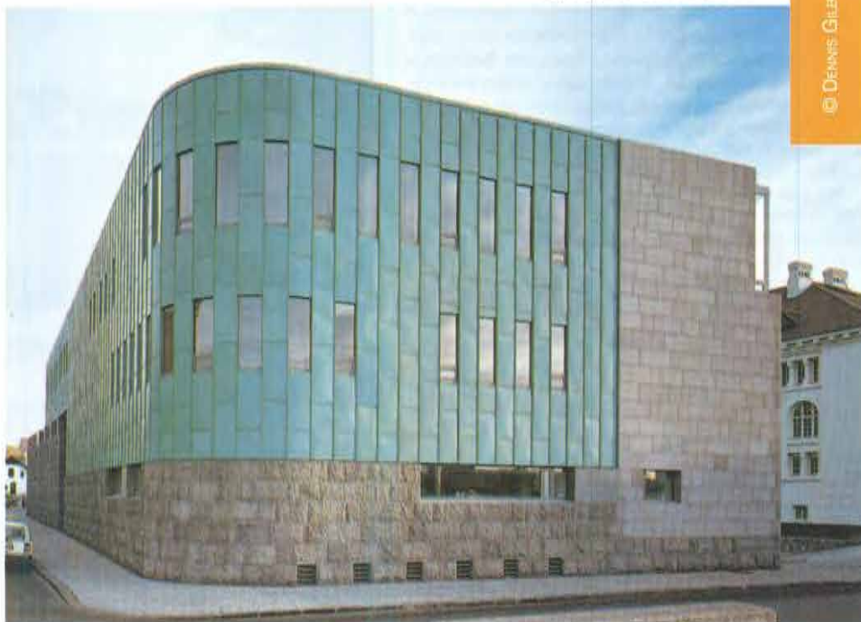
Vista dell'angolo di nord ovest
