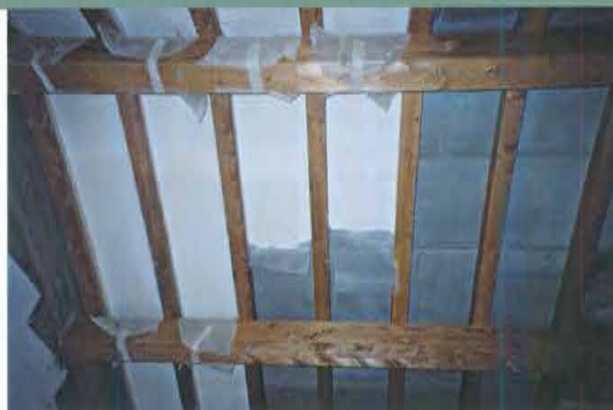
L'estradosso del solaio dove è possibile notare i travetti
