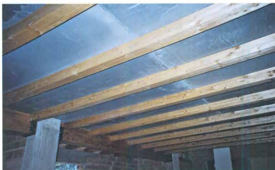
L'intradosso del solaio
