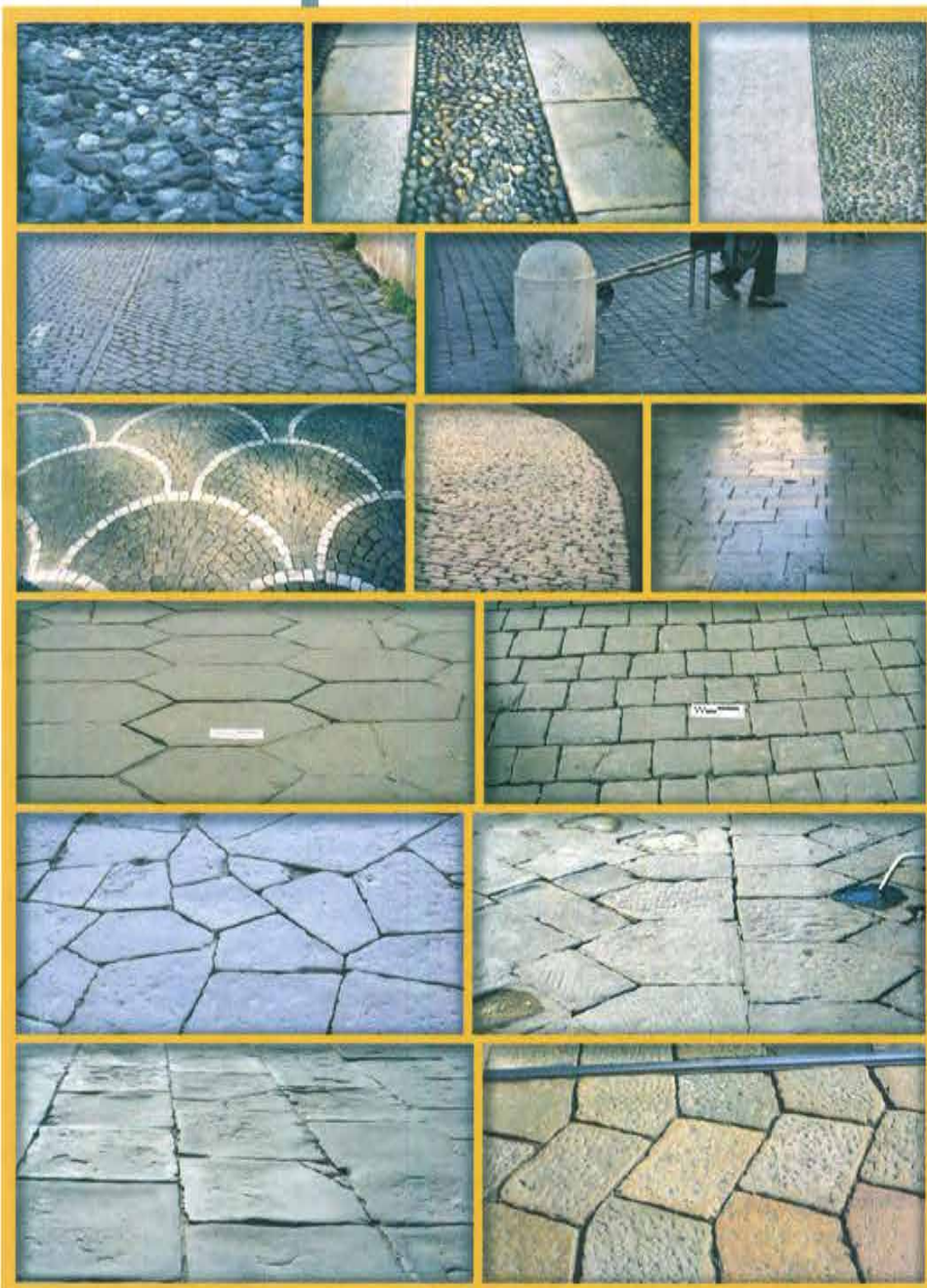
Pavimentazioni lapidee tradizionali; dall'alto verso il basso troviamo in sequenza pavimentazioni in acciottolato, selciato, lastricato
