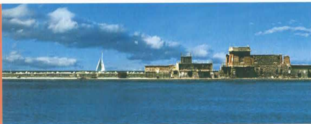
La diga foranea, originariamente lembo di protezione dei tre ampi bacini del Porto Antico, parallela rispetto al piano di banchina e posta a 150 metri dai moli FOTO DI GABRIELE CROZZOLI
