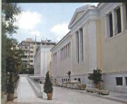
Vista del lato nord con la nuova entrata per i disabili dalla via V. Irakleiou
