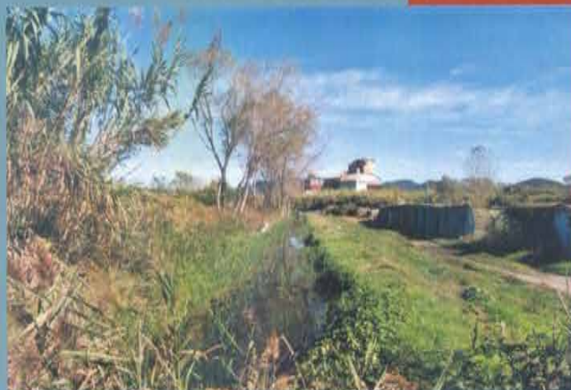
Il rilevato dell'ex Ferrovia delle Torbiere e l'edificio della Tramoggia
