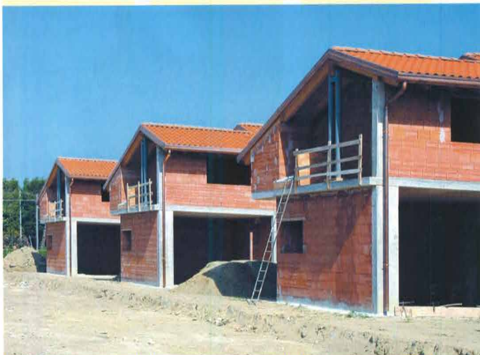
Cantiere di Zero Branco (Tv) con le villette in costruzione
