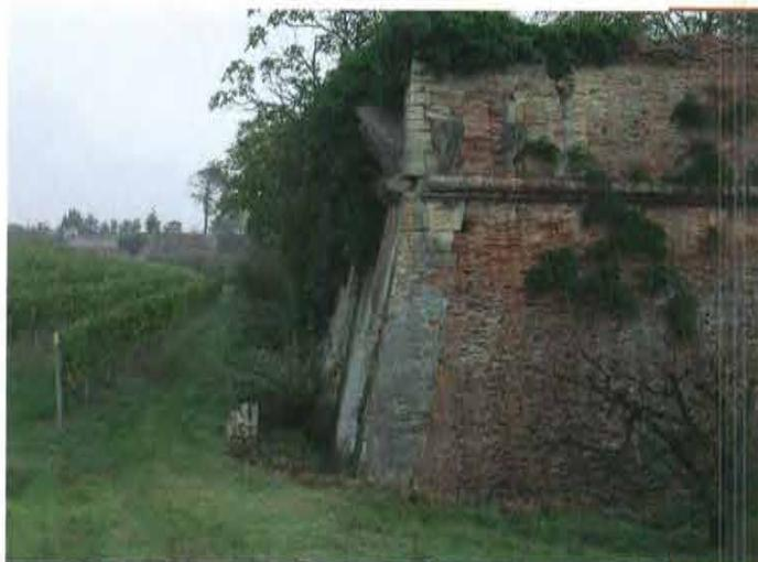
*Bastione di Santa Reparata visto dall'esterno. Si notino la struttura in laterizio e i blocchi angolari di pietra "spungone"*
