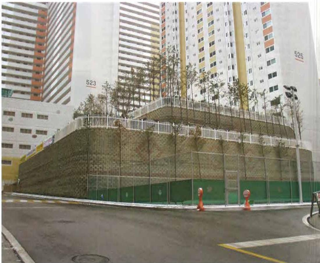
blocchi risulta molto importante per muri di sostegno realizzati in prossimità di vie di comunicazione o centri abitati in quanto l'energia riflessa viene ridotta e l'impatto acustico limitato.
