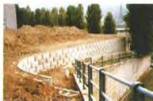
*Un muro di contenimento in fase di realizzazione: i blocchi non pongono limiti alla forma architettonica dell'opera*
