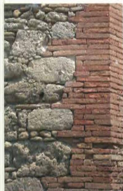
*Dettaglio della tessitura muraria che caratterizza alcuni dei principali palazzi della cittadella fortificata di "Terra del Sole". Si noti il particolare sistema di montaggio degli elementi laterizi che costituiscono lo spigolo del paramento*
