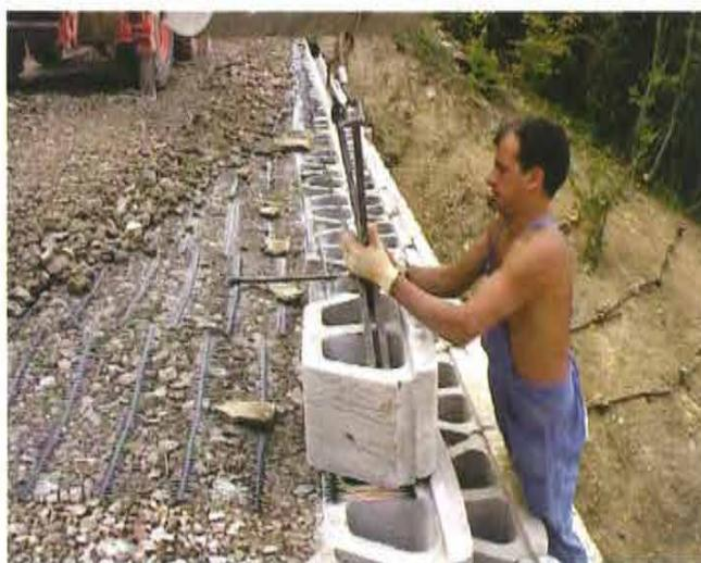
un alleggerimento della struttura di facciata che non resiste più alle spinte solo per gravità o per reazione d'incastro alla base, ma usufruisce della resistenza a trazione della geogriglia trasferita per attrito al terreno. La grande elasticità dei muri in terra rinforzata Tenax ne consente la realizzazione anche su terreni a debole portanza, perché le strutture sono in grado di adattarsi agli
