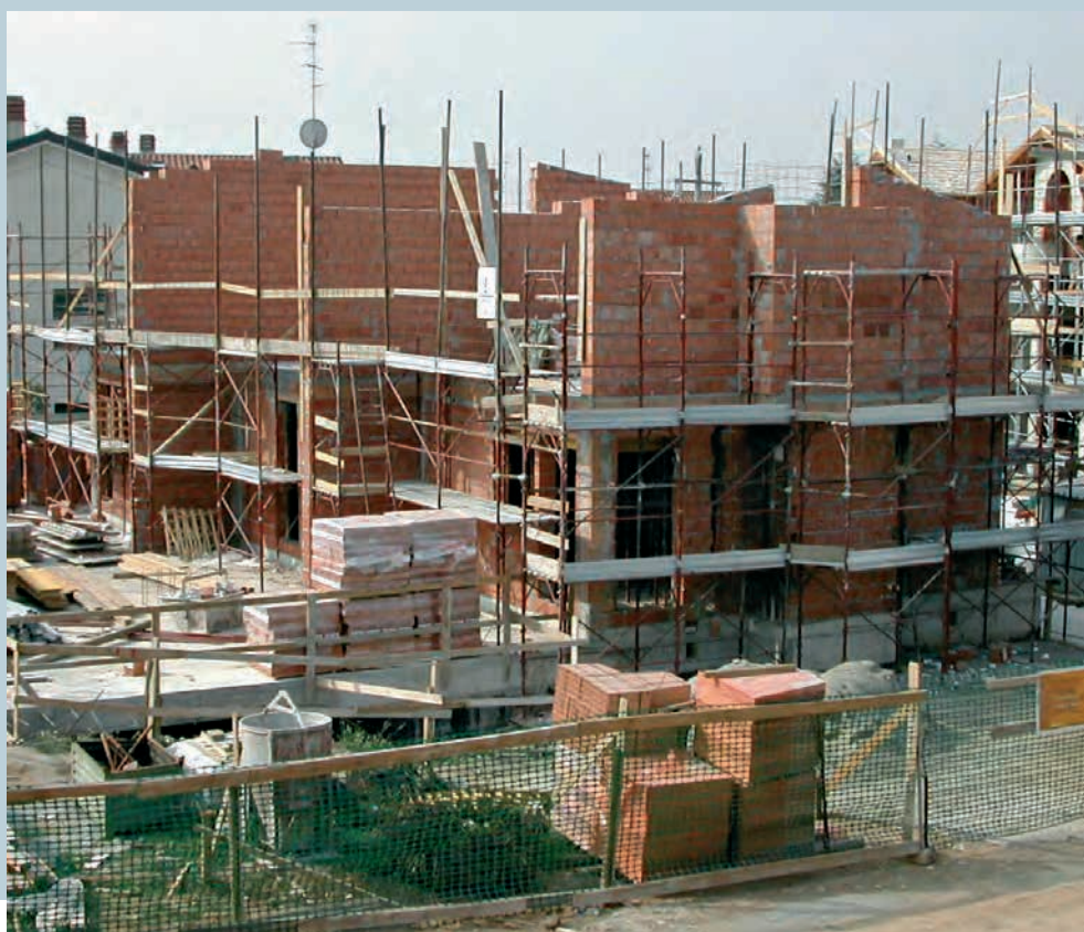
Vista delle strutture del piano primo
