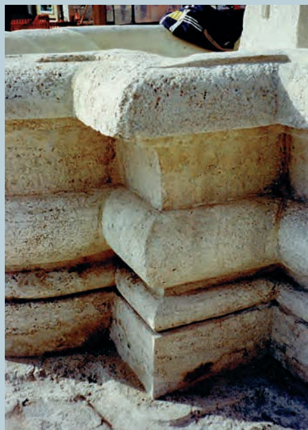
Particolare della fontana prima dell'intervento: sono visibili sul bordo della vasca le pesanti reintegrazioni in malta cementizia
