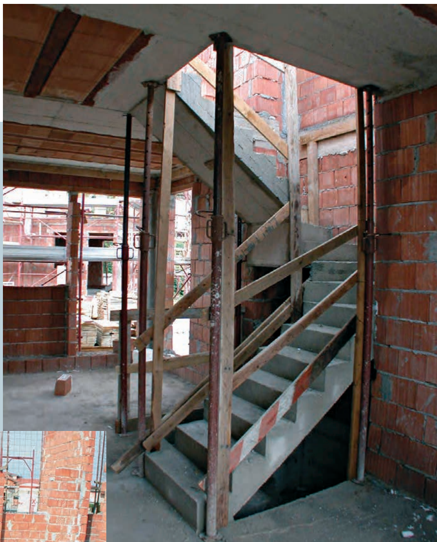
Particolare murature e sbarco scala interna
