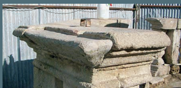
Ricostruzione con calce additivata con polveri di biocalcare e resine acriliche
