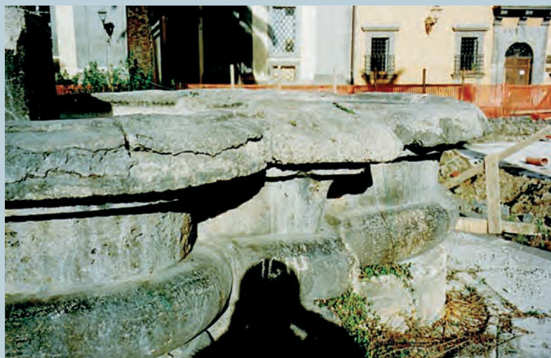
Particolare della fontana prima dell'intervento: sono visibili sul bordo della vasca le pesanti reintegrazioni in malta cementizia
