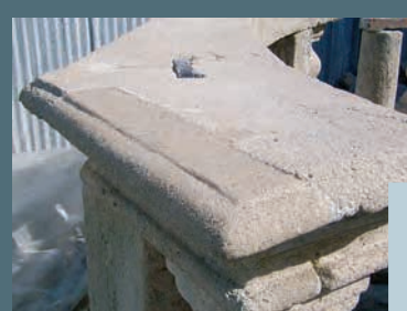
Ricostruzione con calce additivata con polveri di biocalcare e resine acriliche
