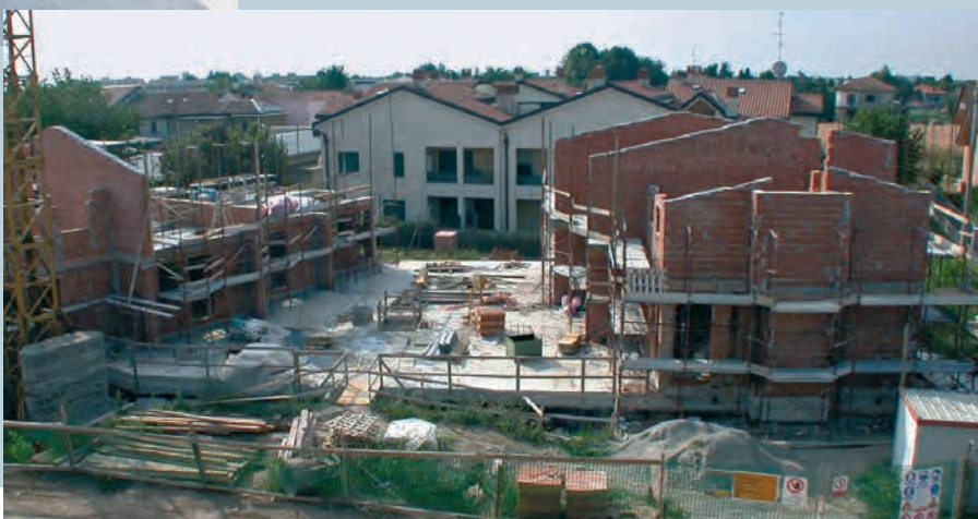
Vista d'insieme delle strutture
