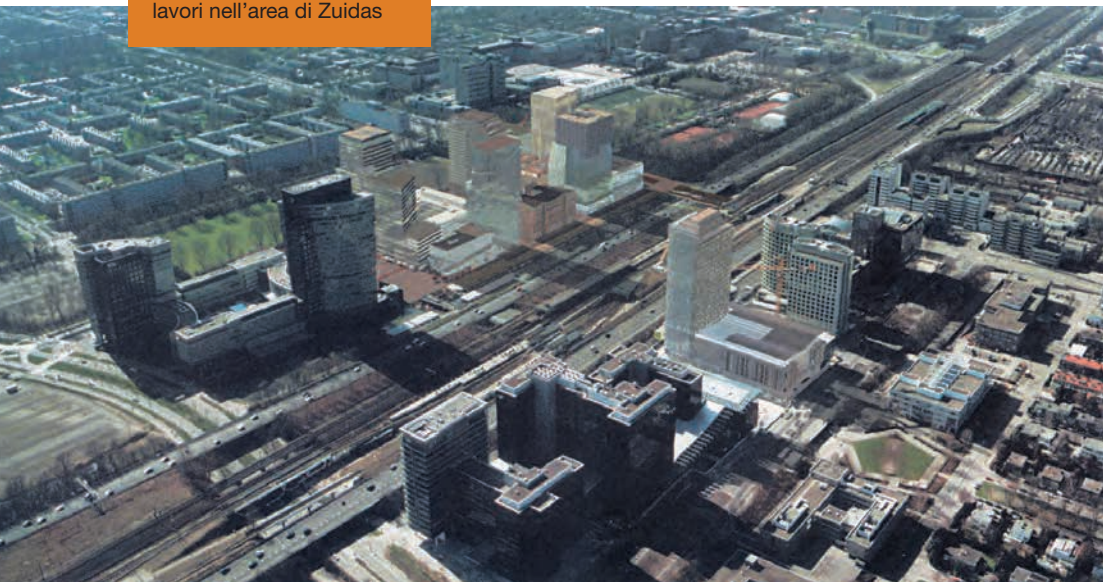
Amsterdam. Stato di avanzamento dei lavori nell'area di Zuidas
