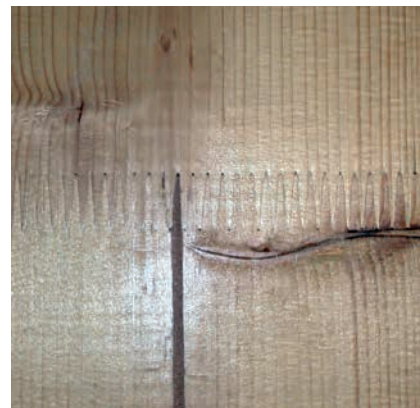
Particolare della struttura dell'elemento portante in legno
