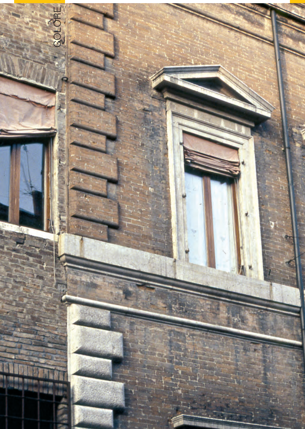
Ferrara palazzo del XVII secolo in via Montebello. Bugne in pietra e in mattoni, in origine tinteggiati
