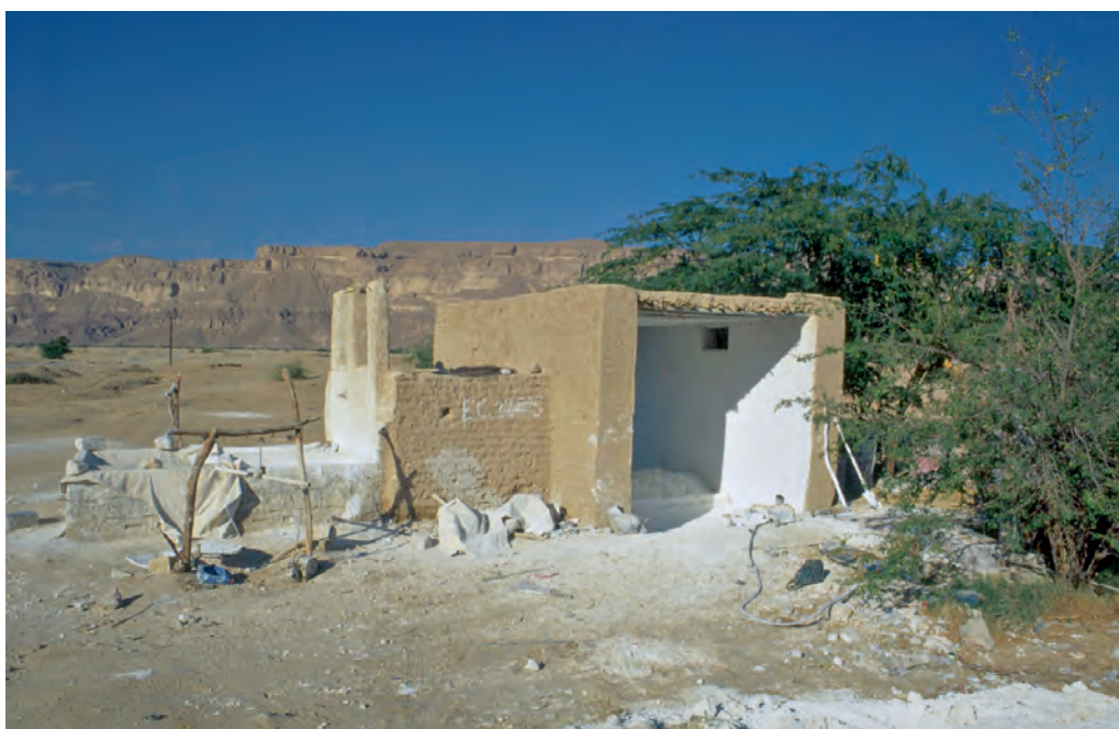
Yemen, fabbricato realizzato con struttura portante in mattoni crudi e finitura dei fronti interni con intonaco a calce
