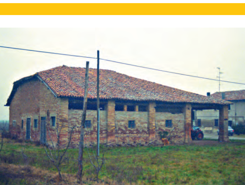
Stalla/fienile con barchessa pilastro in seguito tamponata ad uso stalla
