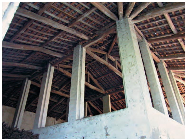
Sistema di copertura in legno, a struttura semplificata rispetto a quella progettata da Carlo Francesco Dotti nel 1734 ed ampliamente diffusa nella pianura bolognese
