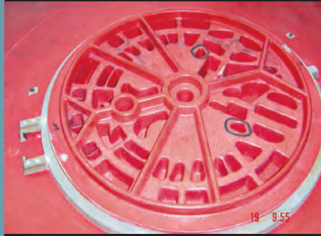
Particolare cerniera di attacco al telaio
