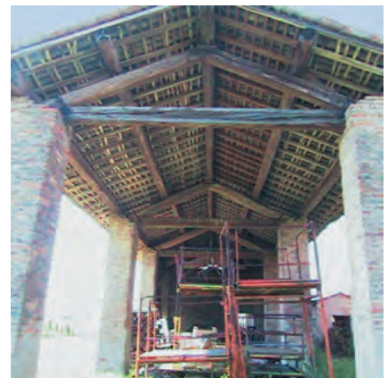
Casella-barchessa isolata, su sei pilastri, con copertura a capanna, capriate in legno ed orditura con scempiato. Le campate tra i pilastri sono denominate "occhi"
