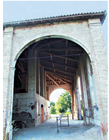
Barchessa pilastro e sistema di copertura con travi, terzere, travetti e scempiato in legno
