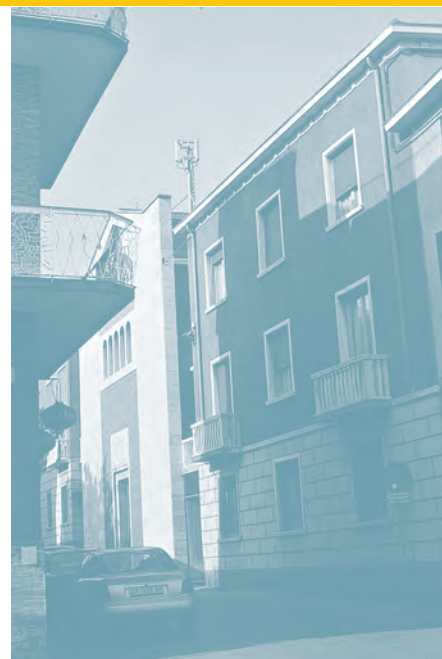
Antenne per la telefonia cellulare a doppia polarizzazione di minor impatto visivo ambientale
