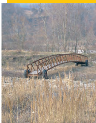
Un ponte su ruote, esistente nel sito ma non utilizzato
