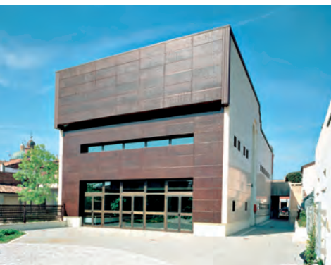
Centro culturale Federico Fellini, fronte interno (recupero 2002). La nuova immagine che ricerca nei materiali di finitura (ferro, ruggine) una specifica relazione con il luogo FOTO LUCA MASSARI
