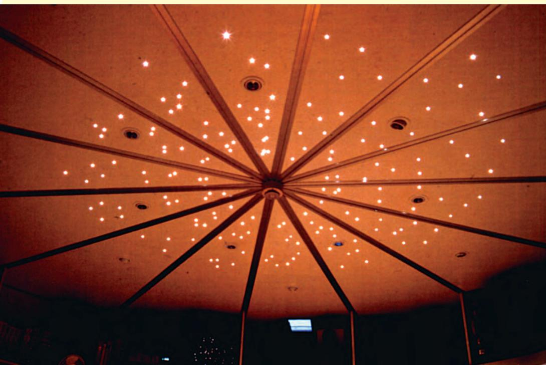
Applicazione decorativa "a cielo stellato", realizzata con l'inserimento di una moltitudine di fibre ottiche, alle quali sono applicati erogatori di luce puntiformi, inseriti in un controsoffitto o in una struttura reticolare. I terminali possono essere puntali ad incasso in cristallo boemo, oppure faretto ad effetto diffusore. L'illuminatore viene collocato in posizione centrale rispetto al sistema
