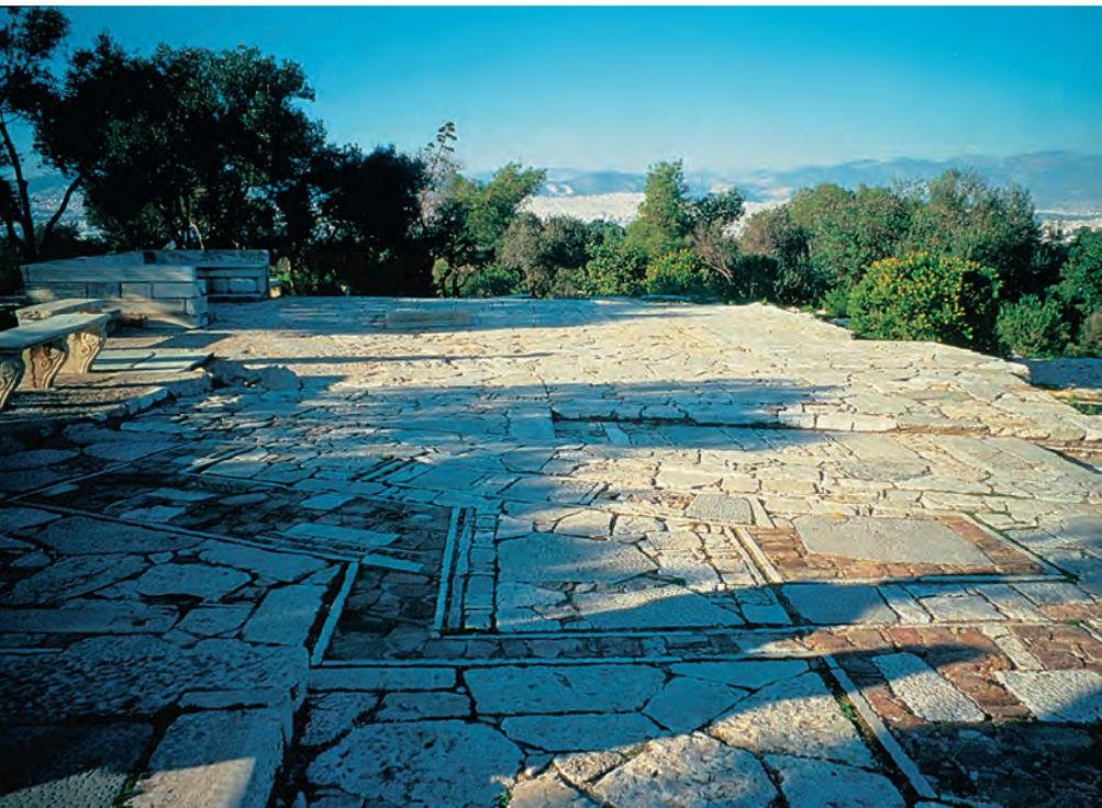
Oltre a suggerire la forma del percorso, il sito, ricchissimo di reperti archeologici anche di scarso valore, fornisce esso stesso il *materiale* per la costruzione. Altri materiali provengono da cave, da residui di lavorazioni lapidee, dalle demolizioni di edifici neoclassici: lastre e pezzi di marmo, frammenti di terracotta, pietre colorate, spezzoni di tegole e anfore, pezzi di elementi costruttivi come cornicioni, trabeazioni, modanature, ecc.
