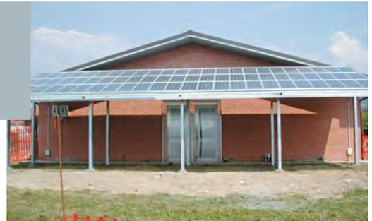
In alcuni casi i moduli fotovoltaici possono essere utilizzati direttamente come protezione solare. La loro integrazione nei sistemi di pensiline la cui struttura risulta indipendente dal fabbricato può essere indicata sia per gli edifici già esistenti che per nuove costruzioni.
